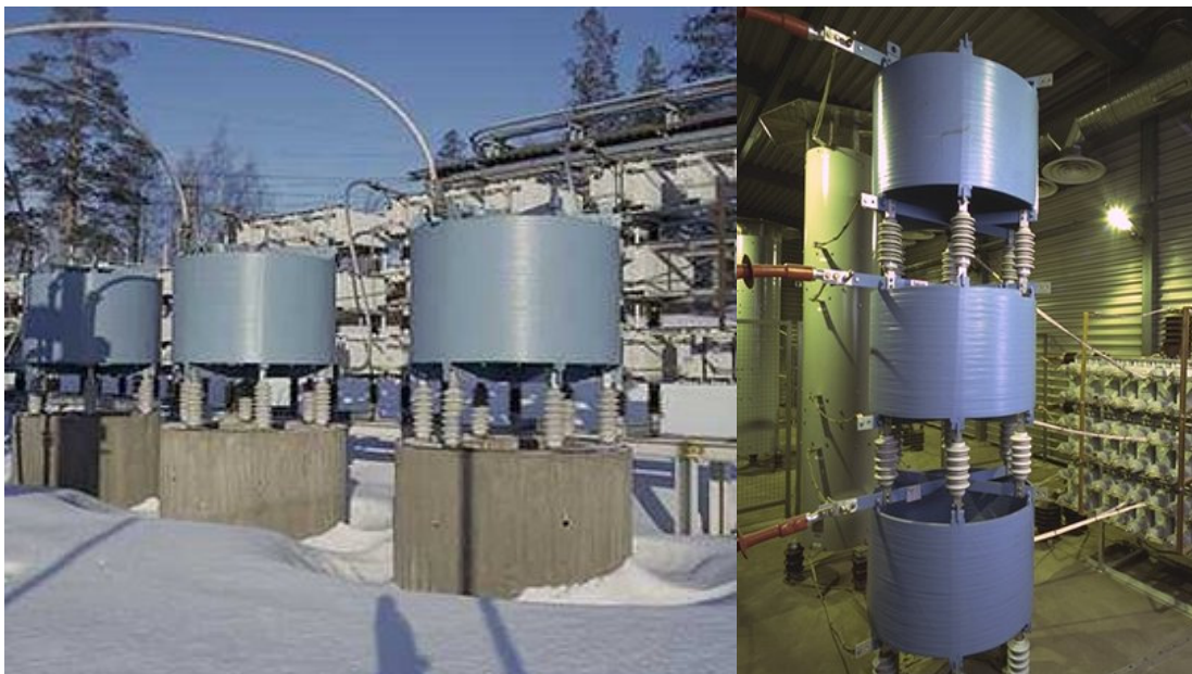
Kuva 9. Kuristimen yksi- ja kolmivaiheinen asennustapa.
