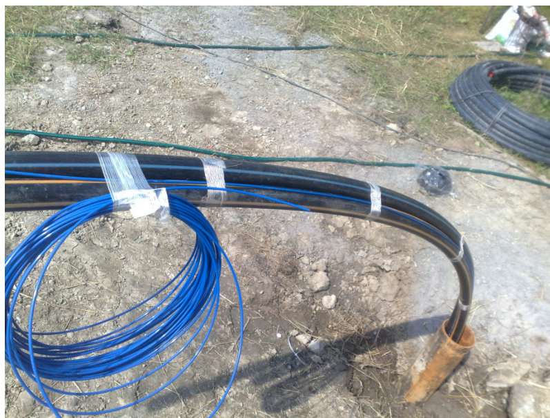
Kuva 3.25. Valokuitukaapeli (sininen) asennetaan lämpökaivoon. (Verte Oy 2012)
