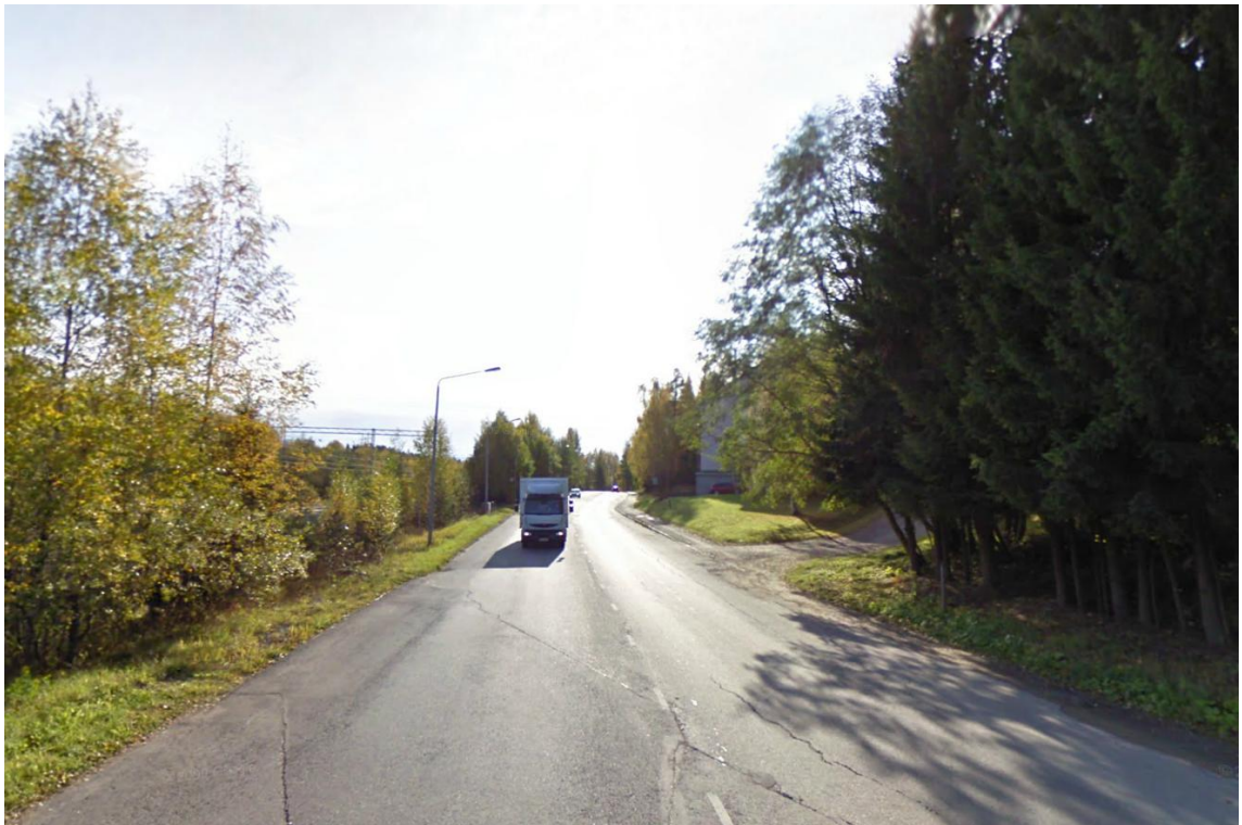
Kuva 31 Pyöräilyväylän epäjatkuvuuskohta Vanajantiellä lähellä Kuusitien liittymää. Lisäksi jalkakäytävä puuttuu osalta matkaa (kuva: Google Maps 2013).
