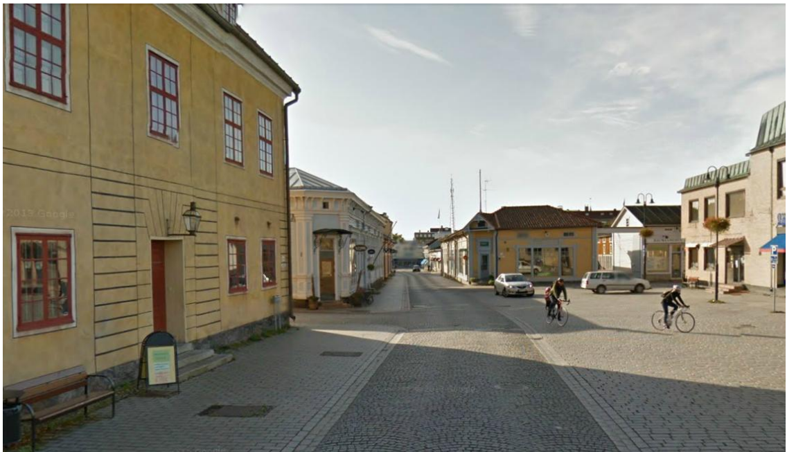
Kuva 49 Shared space -katu Raumalla (Kuninkaankatu). Moottoriajoneuvot, pyöräilijät ja kävelijät jakavat saman katutilan, perinteiset katumerkinnät ja liikennemerkkit on poistettu. (kuva: Google Maps 2013)
