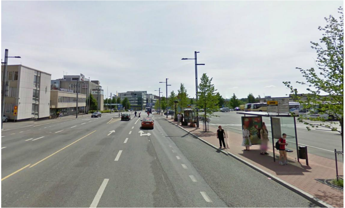
Kuva 40 Linja-autopysäkkikatosten toimiva sijoittelu Tampereella Hatanpään valtatiellä, pyöräilyväylä kulkee pysäkkikatoksen takaa (kuva: Google Maps 2013).
