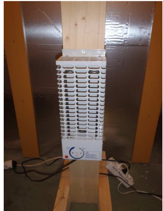
Kuva 3.16 Vasemmalla kosteushuone ja oikealla kosteushuonetta lämmittävä termostaattila varustettu lämmitysvastus.
