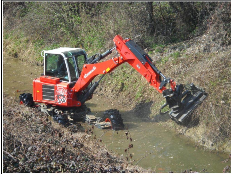
Kuva 3. Euromach kaivinkone raivaamassa ojan penkkoja. [2]
