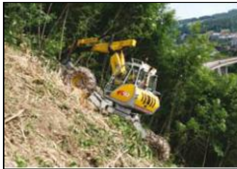
Kuva 2. Menzi Muck-merkinen kaivinkone varustettuna harvesteripäällä. [4]
