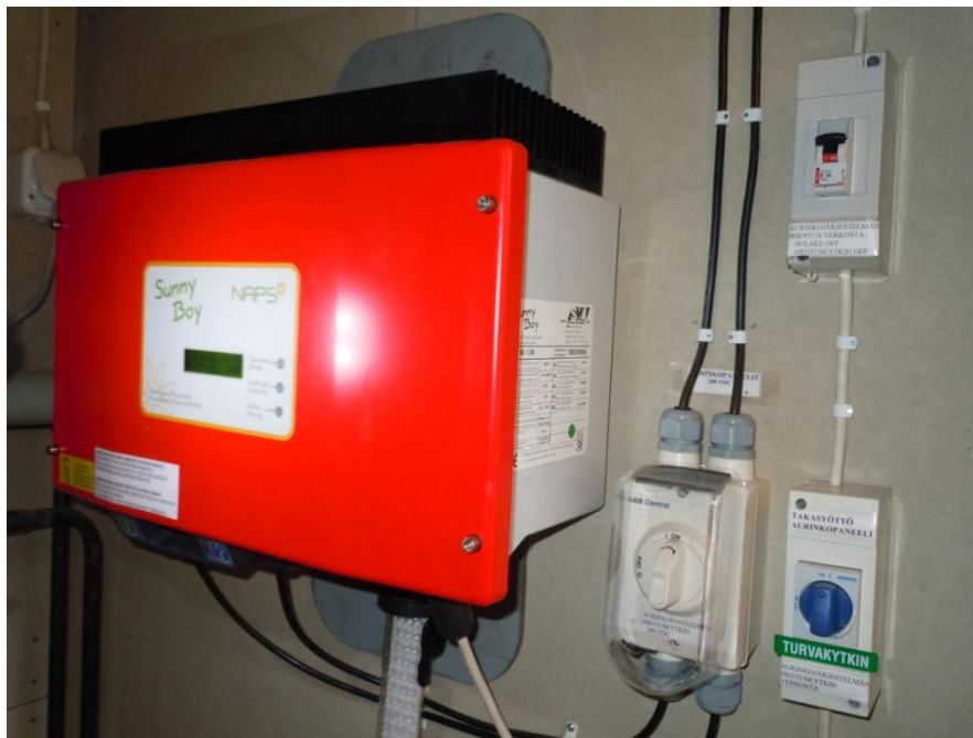
Kuva 3.7. SMA Sunny Boy 1100 -verkkoinvertteri.
