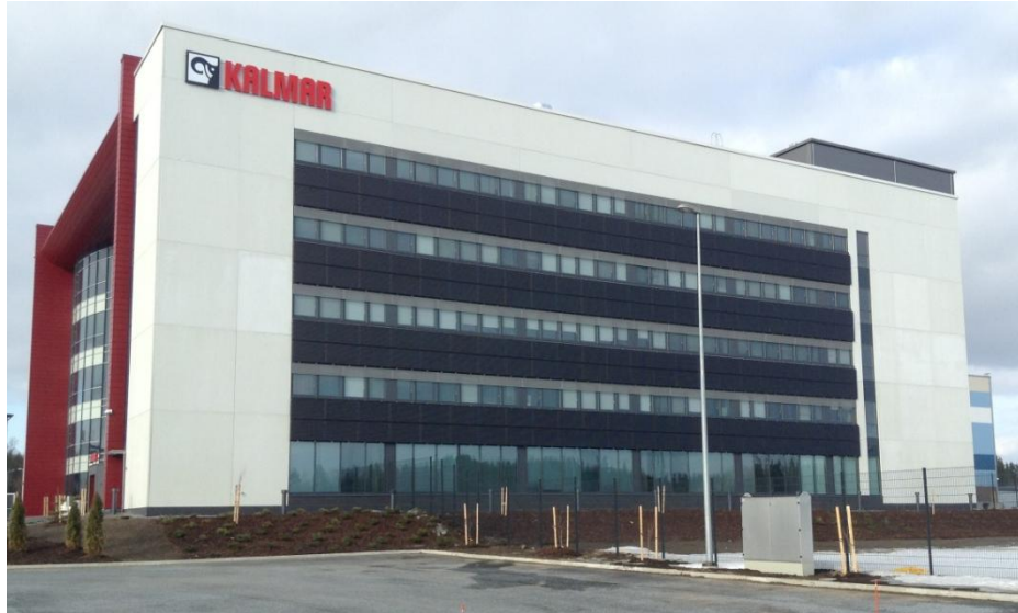
Kuva 4.27. Cargotec Finland Oy:n pääkonttorin seinälle asennettuja paneeleita.
