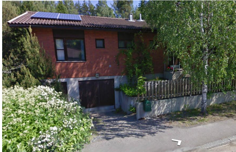
Kuva 4.23. Hervannassa omakotitalon katolle asennetut aurinkopaneelit [70].
