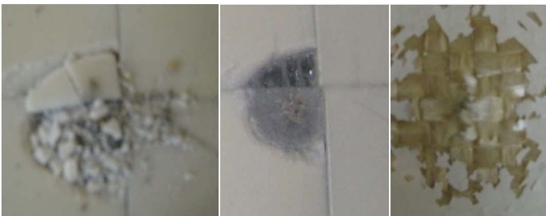
Kuva 9.13. Ohuimman rakenteen läpäissyt osuma. Vasemmalla koskemattomana, keskellä putsattuna ja oikealla paneelin takapuolelta kuvattuna.
