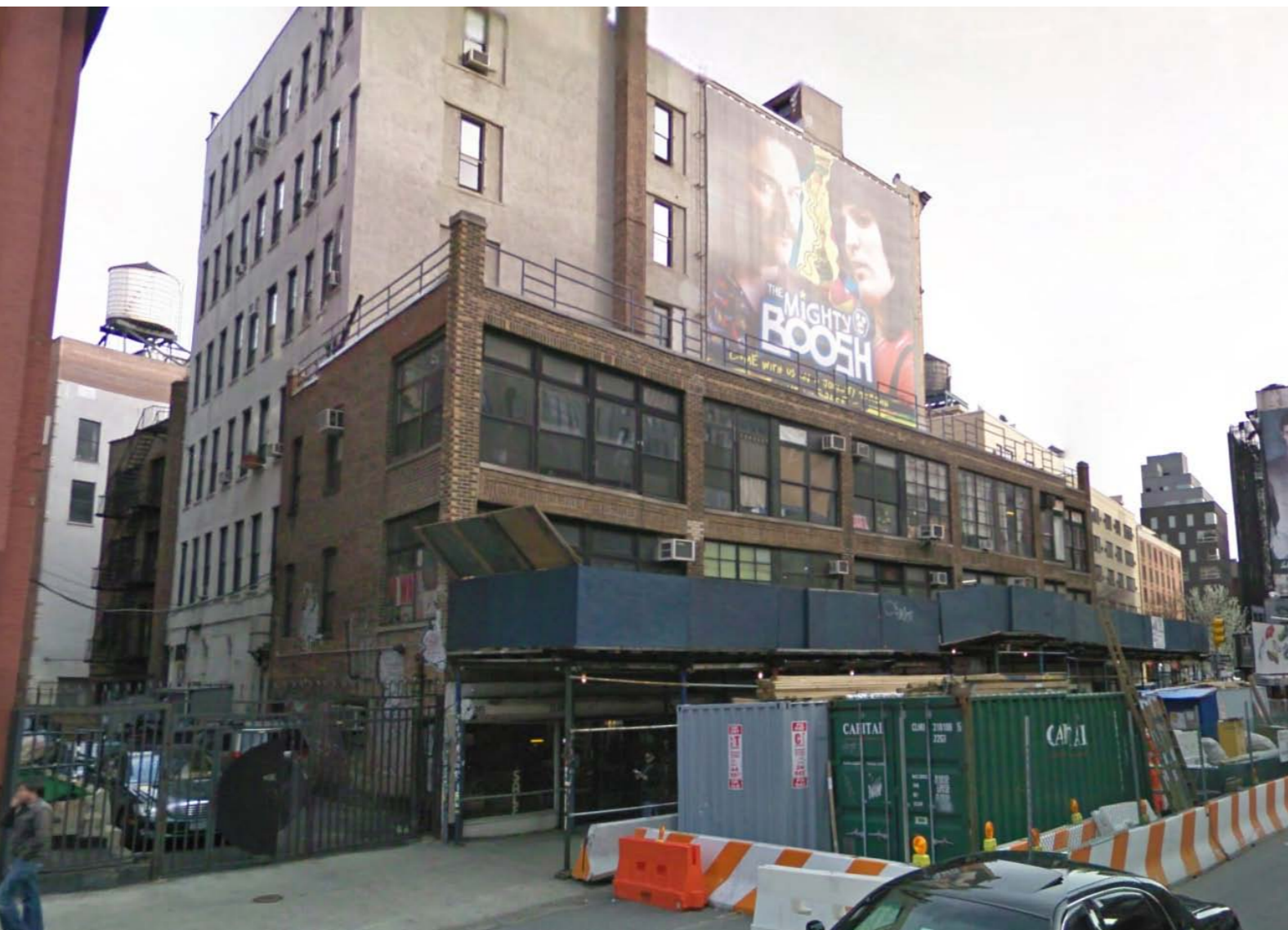
Kuva 3: Kohderakennus kuvattuna Lafayette Streetin varrelta. Julkisivujen edessä seisovat rakennustelineet on määrä pysyä paikallaan siihen saakka kunnes korjaustyöt aloitetaan.
