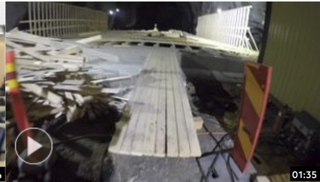
Kuva 8: Moro: Silta tunnelissa
