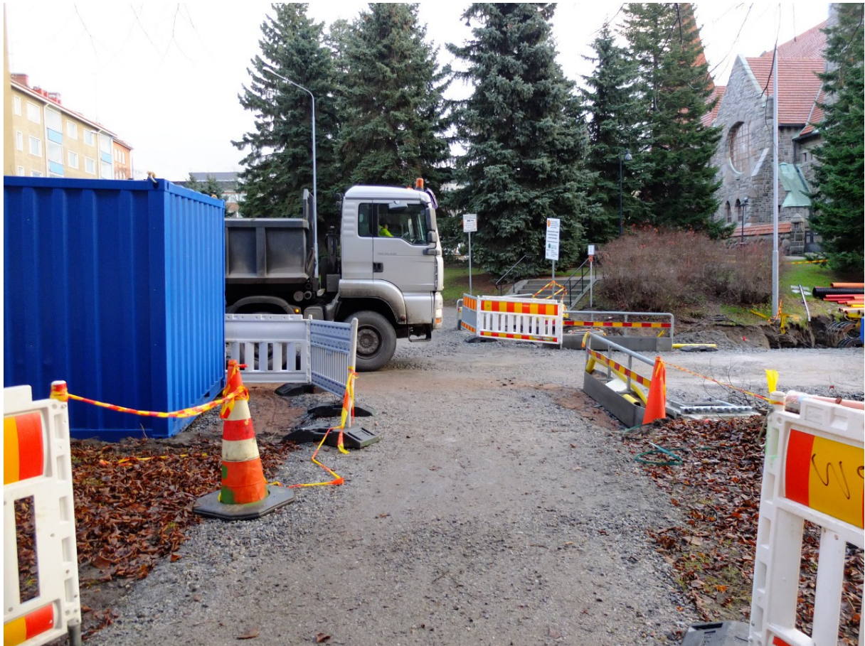
Kuvio 11. ” – – tässä on nyt tämä katutyömaa, muuttanut normaalisti tätä reittiä mutta nyt tästä pääsee ihan näin kätevästi läpi.” (M36, ote kävelyhaastattelusta.)
