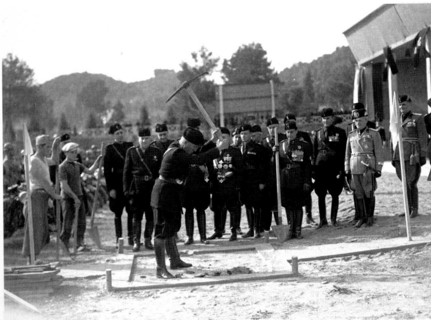
KUVA 13. Mussolini lyö ensimmäiset perustukset Casa Littorian rakennustyömaalla. Lähde: Insolera 2002, s. 38.
