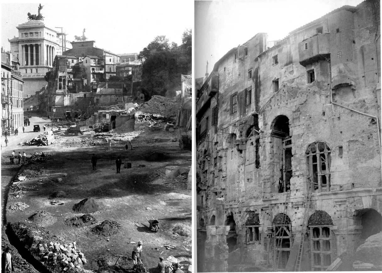
KUVA 23 ja 24. Via del Maren rakennustöitä Capitoliumin juurella. Oikealla vielä ”vapauttamaton” Marcelluksen teatteri keskiaikaisessa asussaan. Lähde: Insolera 2002, s. 108 & 117.
