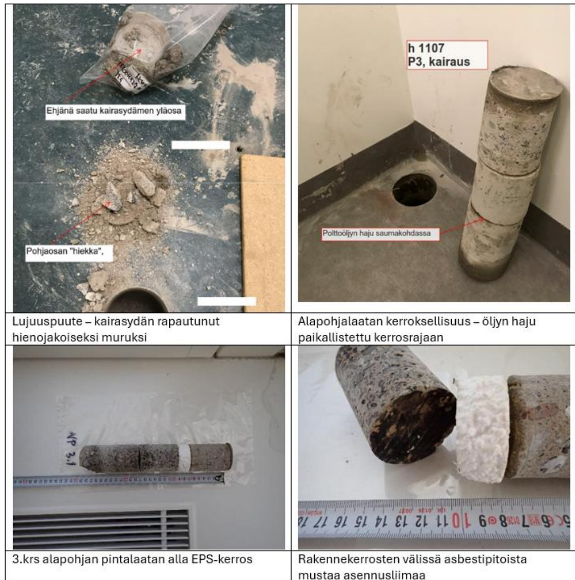
Kuva 19. Lattiarakenteiden näytteiden valokuvia
