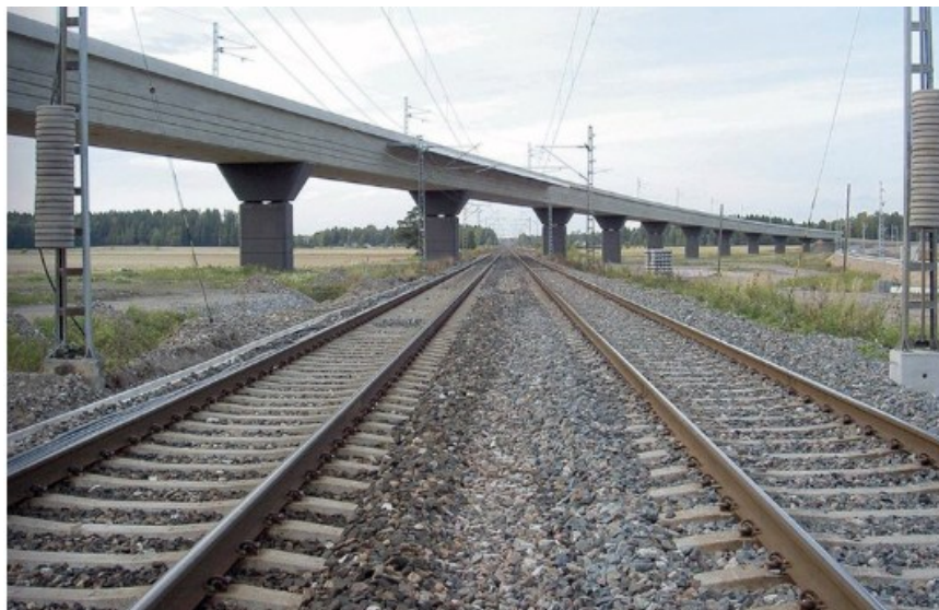
Kuva 14. Betonipölkkyjen käyttöesimerkki: Oikorata Kerava-Lahti (SATEBA 2025).
