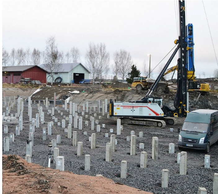
Kuva 5. Maahan asennettuja teräsbetonipaaluja (Rakennusteollisuus 2022, s. 6).
