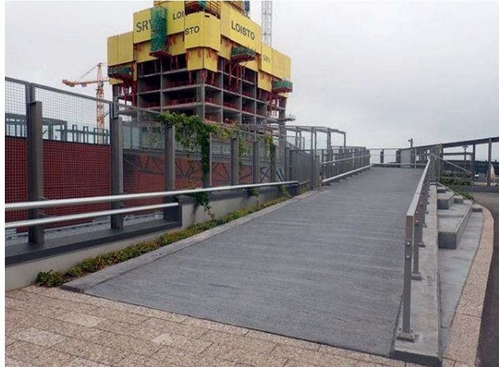
Kuva 13. Paikalla valettu betoniluiska (Betoniteollisuus 2023, s. 175).
