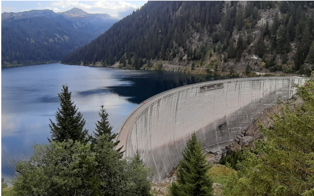
Kuva 19. Massiivinen betonipato (Isomäki 2021).
