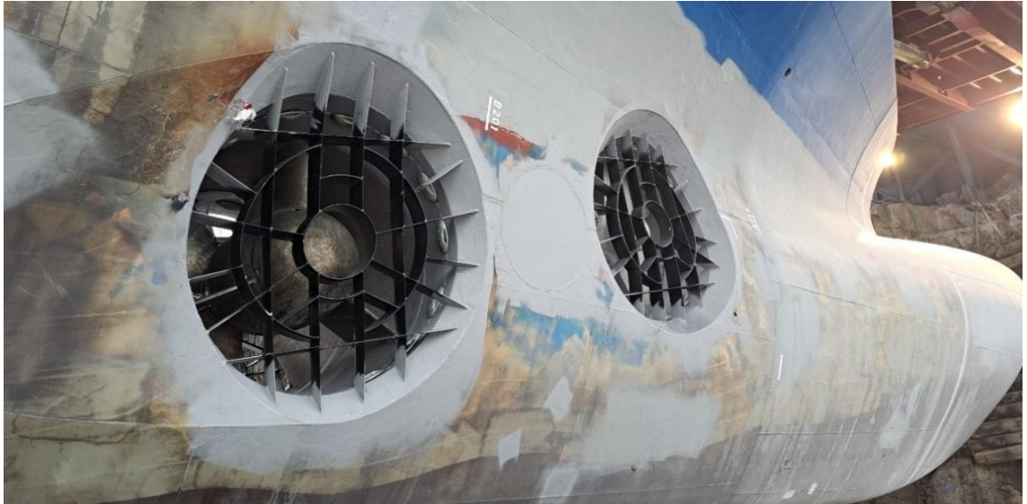
Kuva 16. Elogrid -virtausohjaimet asennettuna M/S Viking Cinderellaan, lähikuva [66].
