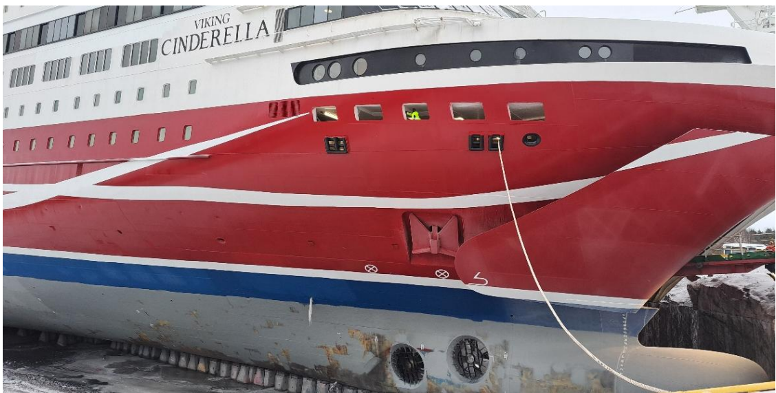
Kuva 17. Elogrid -virtausohjaimet asennettuna M/S Viking Cinderellaan [66].
