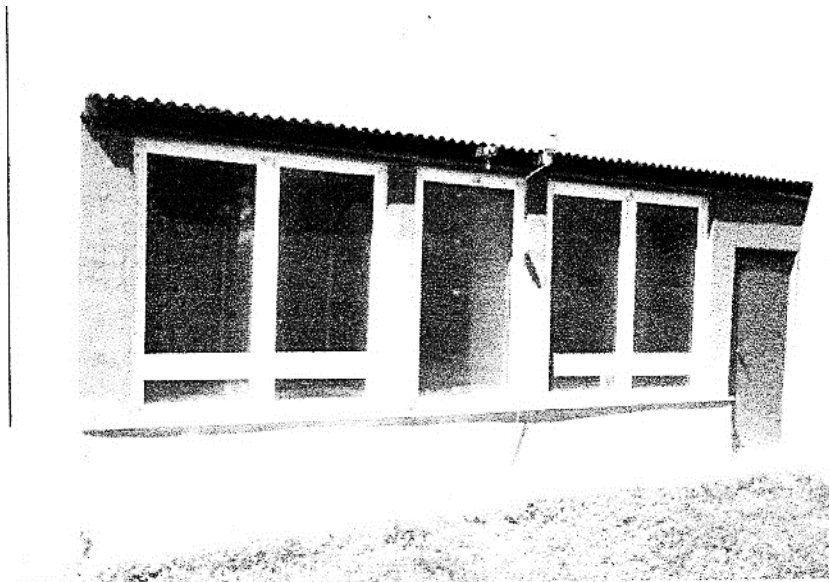
Kuva 6.10. Turkin, Erzurumin testihuoneet, joihin on asennettu kolmilasiset selektiivi-ikkunat, Kara & Kurnuc (2012)
