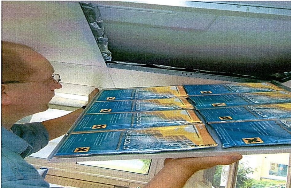
Kuva 6.2. Delta-Cool 24, sijoitettuna kattorakenteisiin
