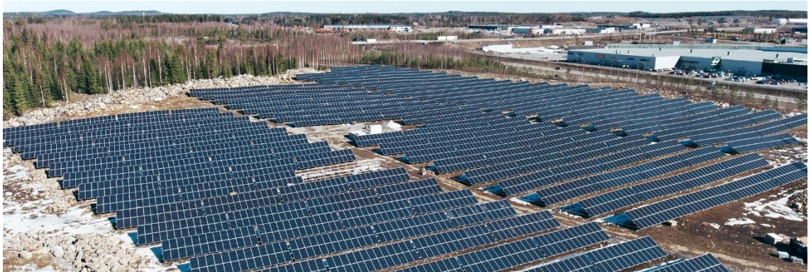
Kuva 5. Lempäälän aurinkovoimala. Lainattu lähteestä [40].
