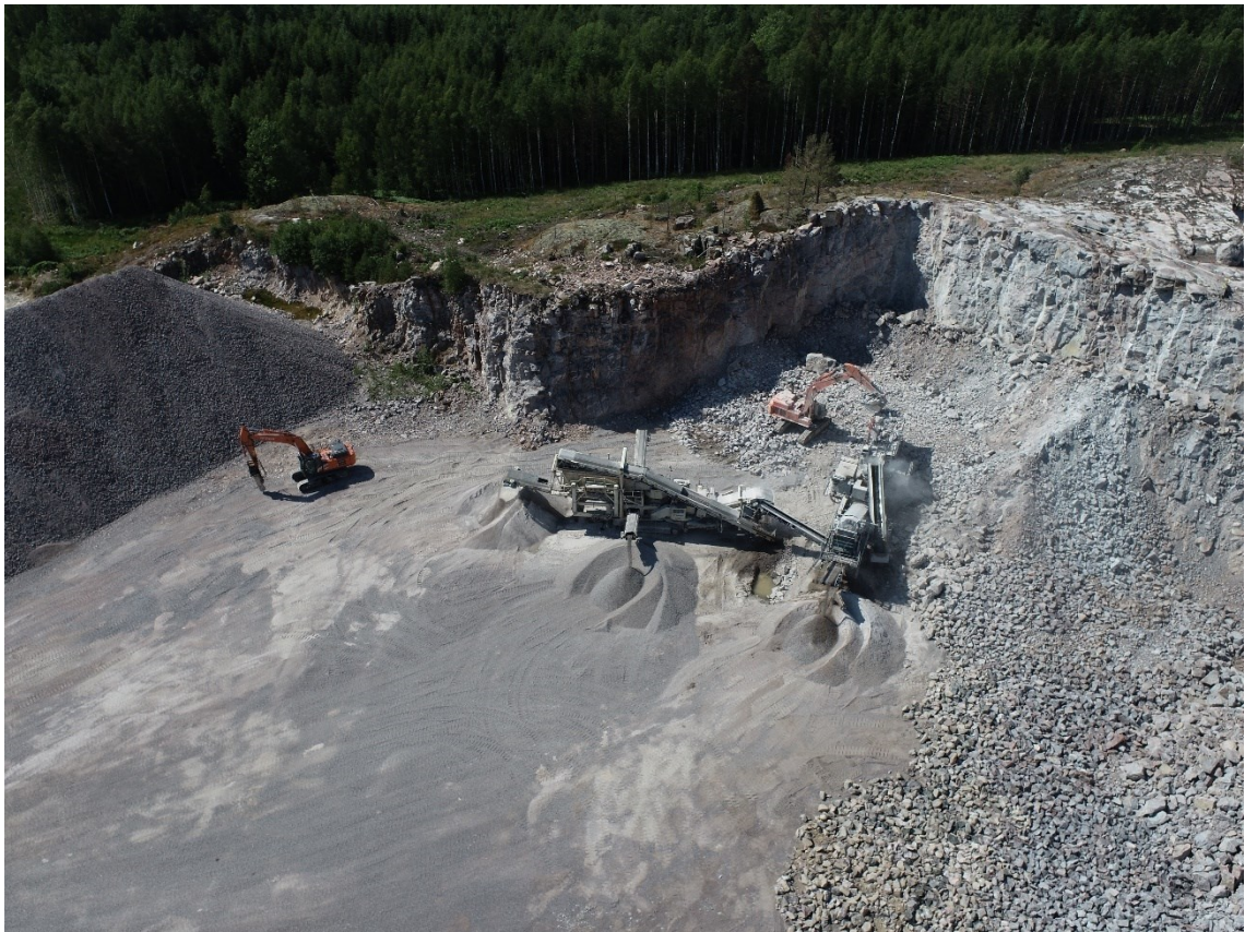
Kuva 8. Kallionmurskauslaitos Destian työmaalla.
