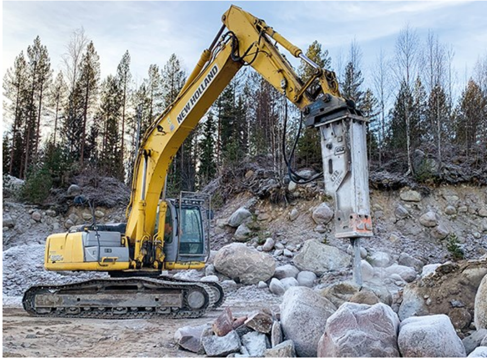
Kuva 16. Kaivinkone, johon kiinnitetty hydraulinen iskuvasara (Kivirock-lehti 2019).
