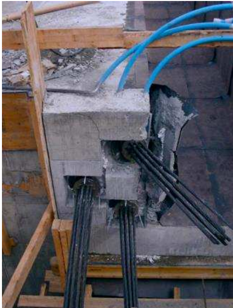
Kuva 4. Esimerkki raudoituksen ja ankkurointialueen vähimmäisetäisyyksien alittumisesta (Laaksonen 2024c, s. 11).
