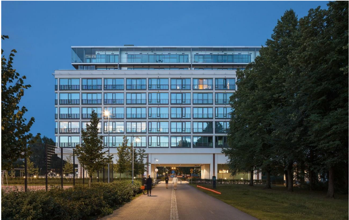
Kuva 5. Munkkiniemen Kone (Arkkitehtiryhmä A6 2019)
