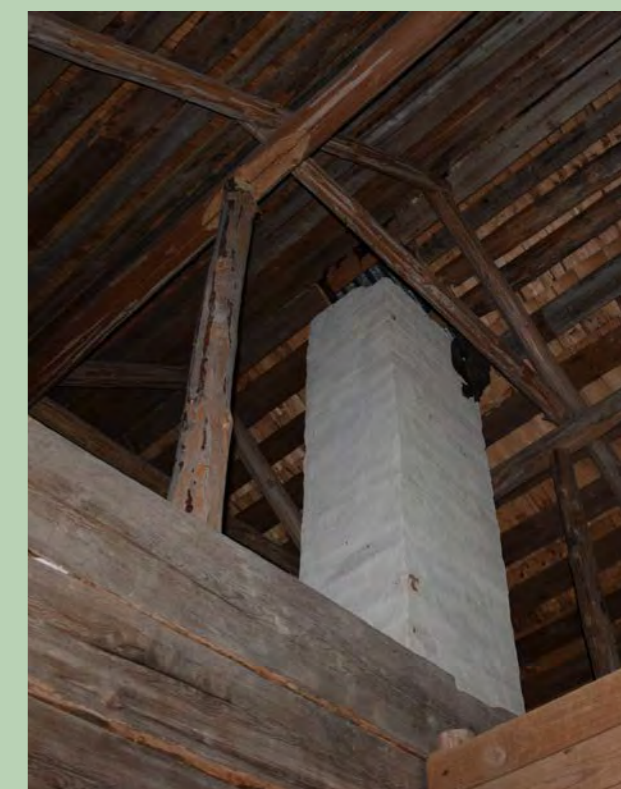
Kuva 365. Ainoastaan tuvalla on alakatto. Eteinen ja varasto ovat avoinna vesikattoon asti. (Paavilainen, 2023)
