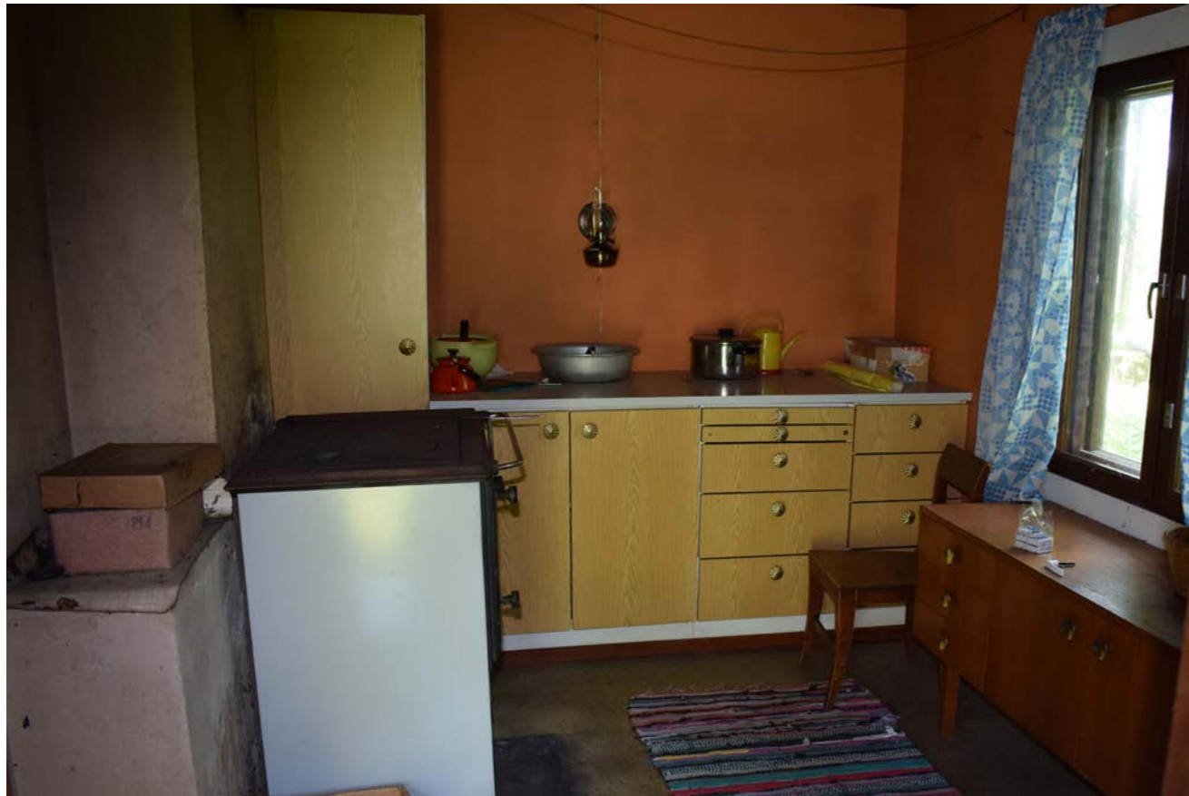
Kuva 279. Keittiö. Lattiat, seinät, katto ja kaapistot on uusittu vuonna 1976. Puuhella on vaihdettu 1980-luvulla. (Paavilainen, 2023)
