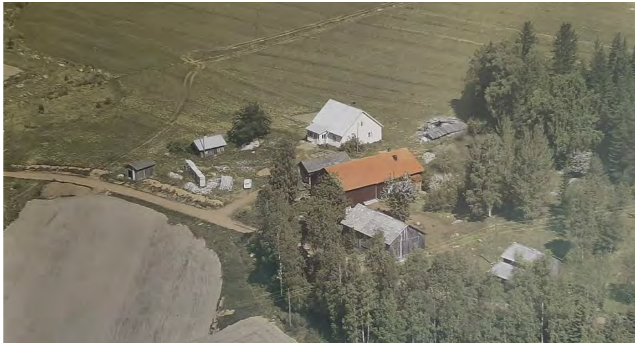
Kuva 132. Ilmakuva pihapiiristä 1960-luvulta. Asuinrakennuksessa uusi katto ja julkisivun vuorattu. Vanha navetta on purettu ja uusi on rakennettu pihapiirin keskelle. (Ilmakuva Hailun omistajalta.)
