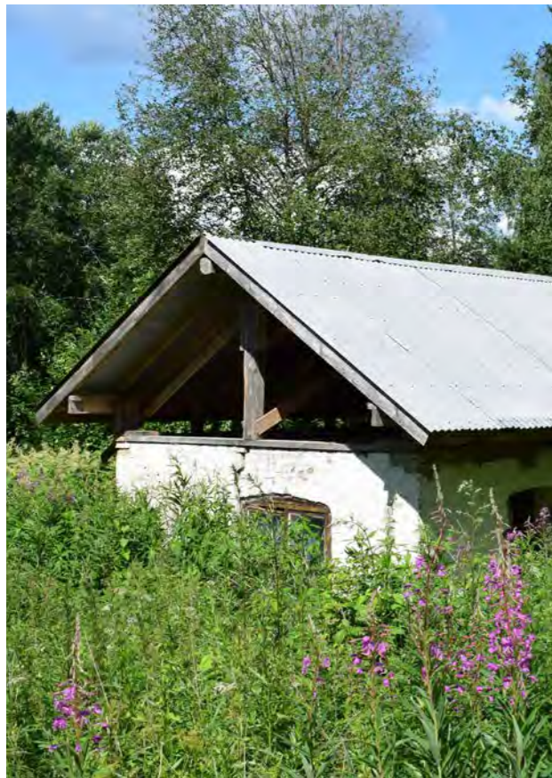
Kuva 385. Navetan kattorakenteet ja vesikatto on tehty uudestaan vuonna 2019. (Paavilainen, 2023)
