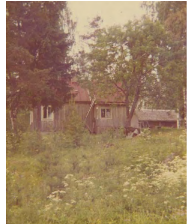
Kuva 156. Asuinrakennus maalaamattomana vuonna 1974. (Kuva Koivumäen omistajalta.)
