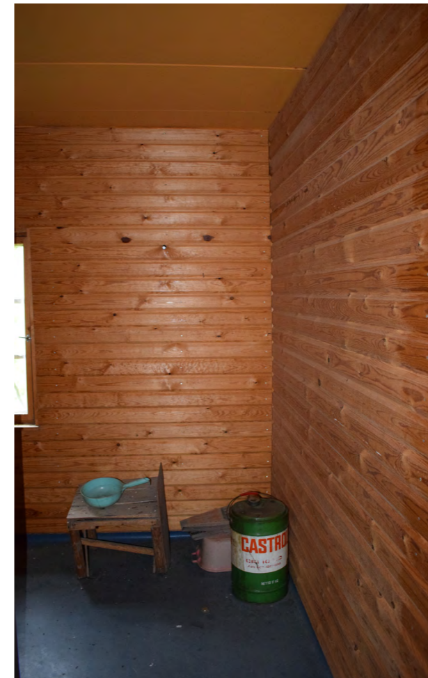
Kuva 344. Rakennukseen ei tule juoksevaa vettä, vaan vesi on haettu läheisestä Myllyojasta. (Paavilainen, 2023)
