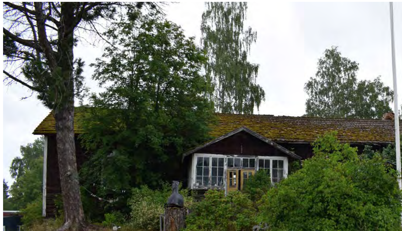
Kuva 27. Länsipäädyn laajennusosa, johon tehtiin sali, kamari, eteinen ja kuisti, on 1800-luvun loppupuolelta. (Paavilainen, 2023)
