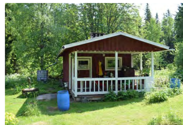
Kuva 274. Nykyään Takamaalla yövytään pääasiassa saunarakennuksessa. (Paavilainen, 2023)
