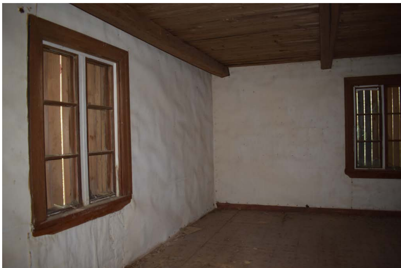
Kuva 361. Tupa on ainoa eristetty huone rakennuksessa. (Paavilainen, 2023)
