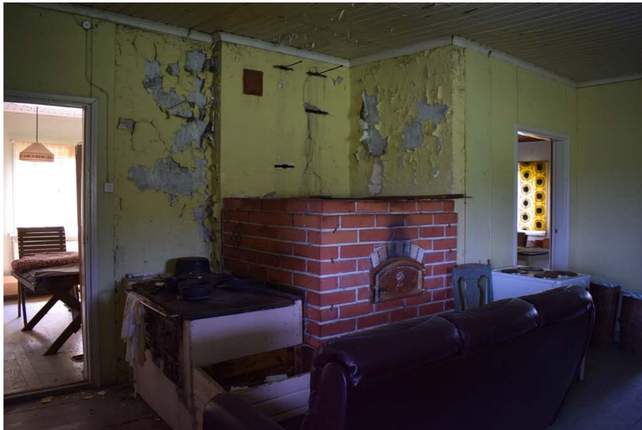
Kuva 143. Keittiössä on tiilinen leivinuuni ja puuhella. (Paavilainen, 2023)
