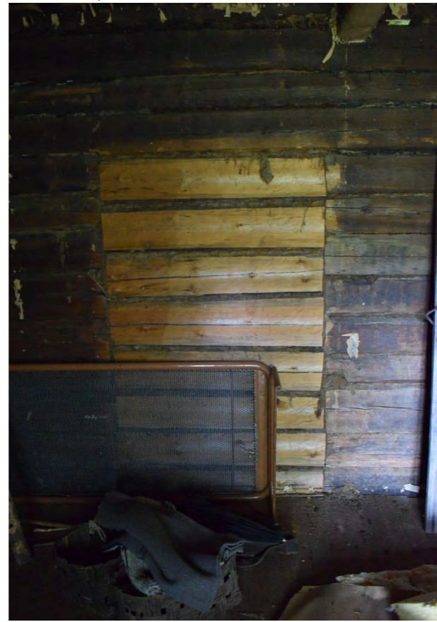
Kuva 392. Kamarin ja eteisen välinen oviaukko on tukittu 1950-luvulla. (Paavilainen, 2023)
