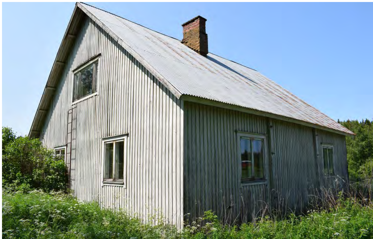
Kuva 136. Kuva rakennuksen itäkulmauksesta, jossa näkyvät talon koillis- ja kaakkoisjulkisivut. Pirtin ikkunan eteen on kasvanut suuri syreeni. (Paavilainen, 2023)
