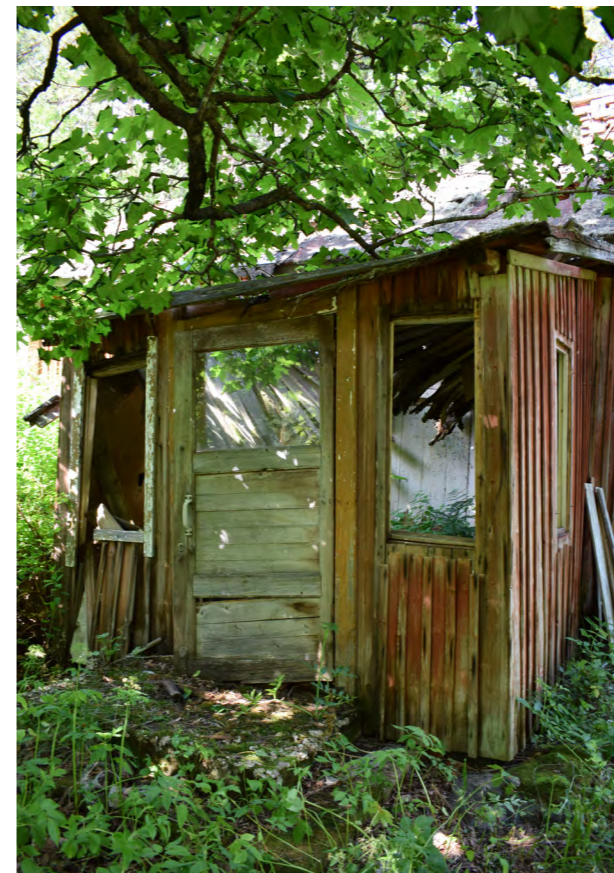
Kuva 200. Kuisti ulkoa. (Paavilainen, 2023)
