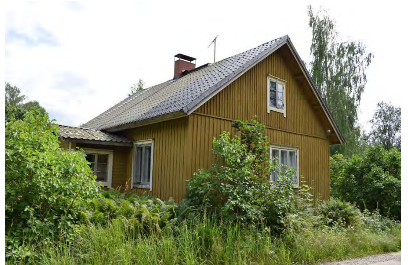
Kuva 98. Asuinrakennus Hirvijärventieltä luoteen puolelta. (Paavilainen, 2023)
