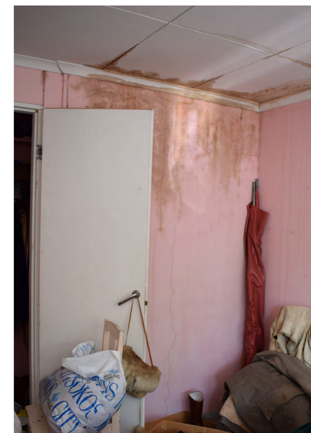
Kuva 449. Yläkerran makuuhuoneen seinä- ja kattolevyt ovat aikanaan kastuneet. (Paavilainen, 2023)
