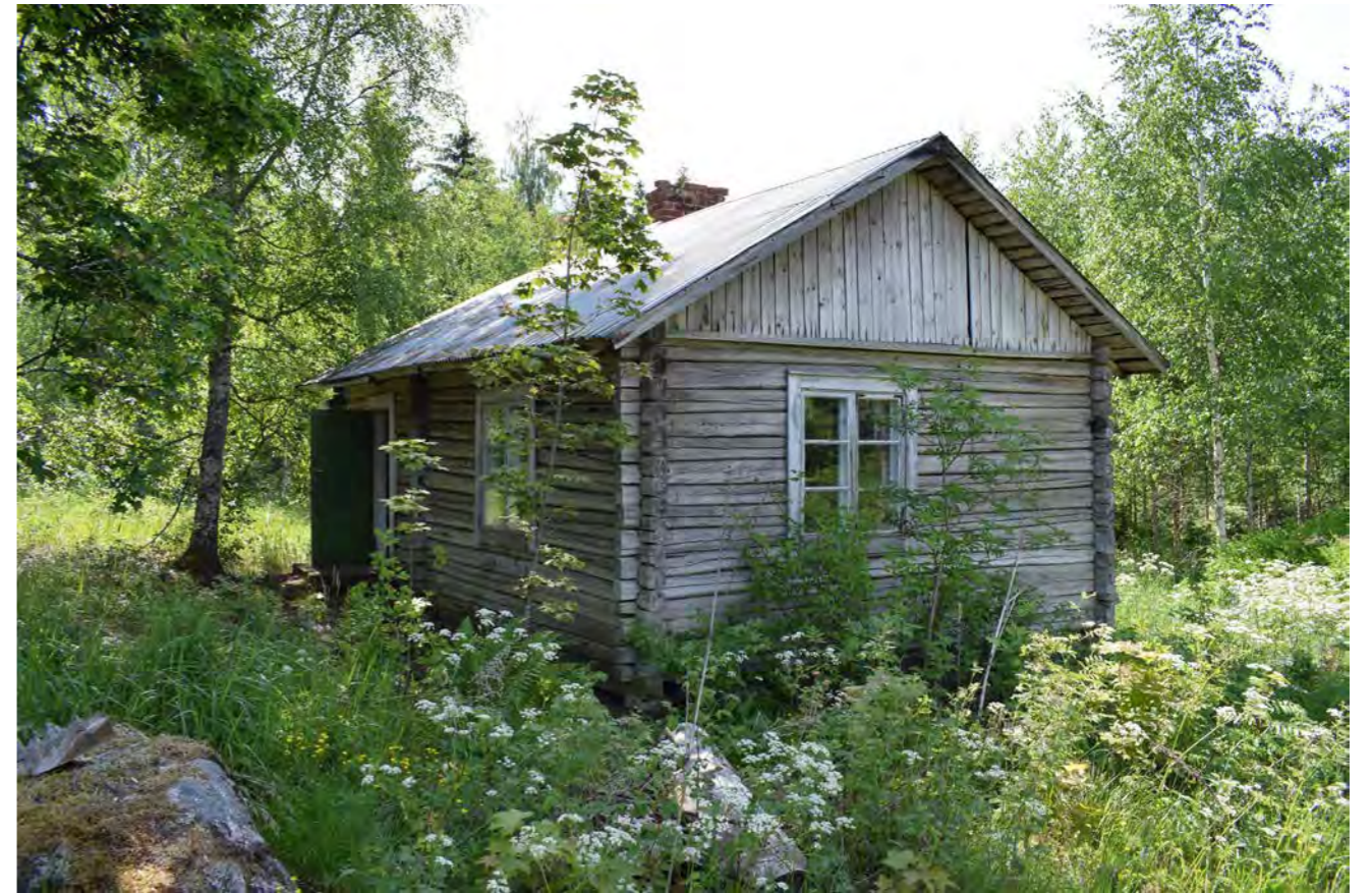
Kuva 217. Asuinrakennus pohjoisesta. Sisäänkäynti on koillissivulla. (Paavilainen, 2023)
