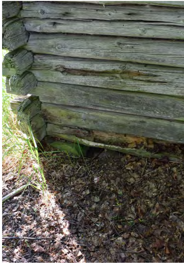
Kuva 223. Koillisen puolella alimmat hirret ovat kiinni maassa ja ovat siten päässeet lahoamaan. (Paavilainen, 2023)
