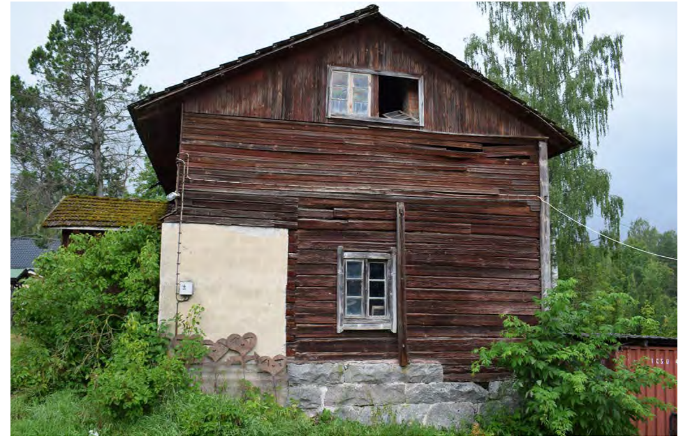
Kuva 35. Itäinen päätyjulkisivu. 1950-luvulla rakennettu betoninen kylmiö on rakennuksen kaakkoskulmassa. Päädyn alaosan hirret on jätetty vuoraamatta, toisin kuin muualla talossa. (Paavilainen, 2023)
