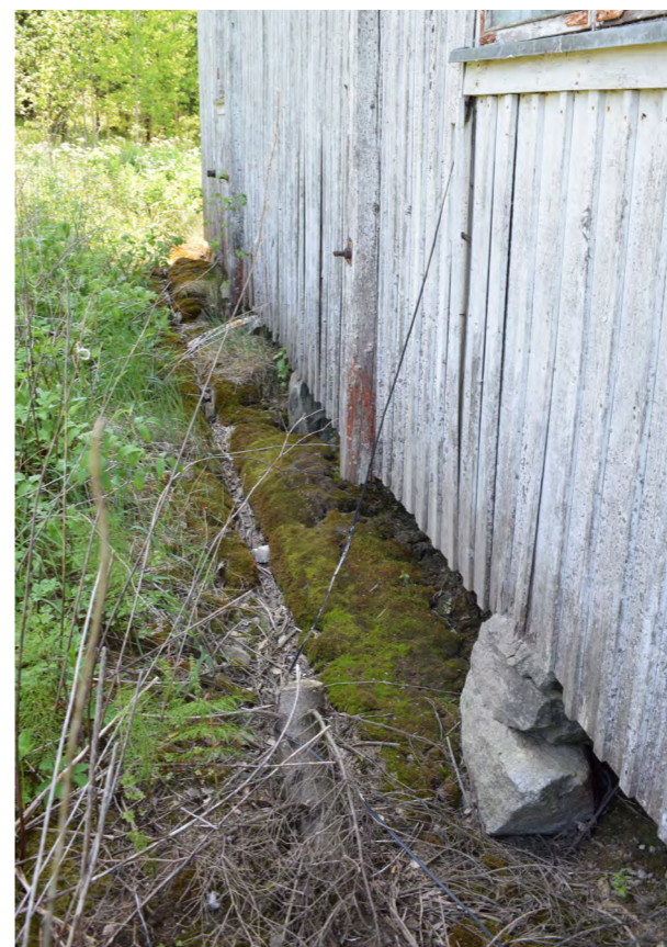
Kuva 446. Perustukset ja takaseinän följärit. (Paavilainen, 2023)
