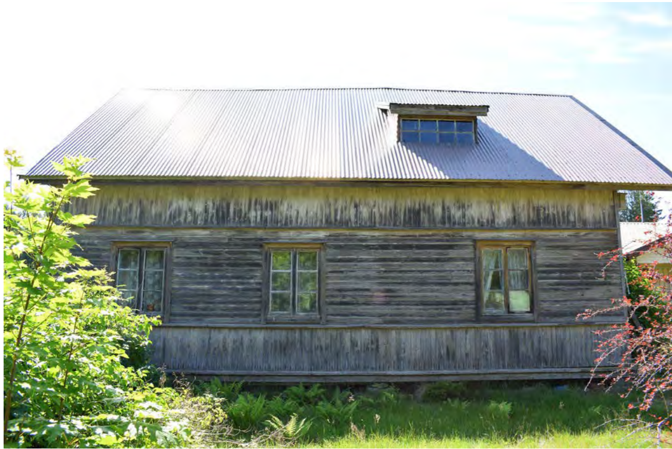
Kuva 244. Koillinen julkisivu. (Paavilainen, 2023)
