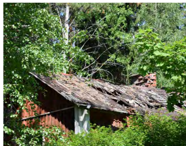
✓ Kuva 205. Katossa on ollut kolmiorimahuopa. (Paavilainen, 2023)
