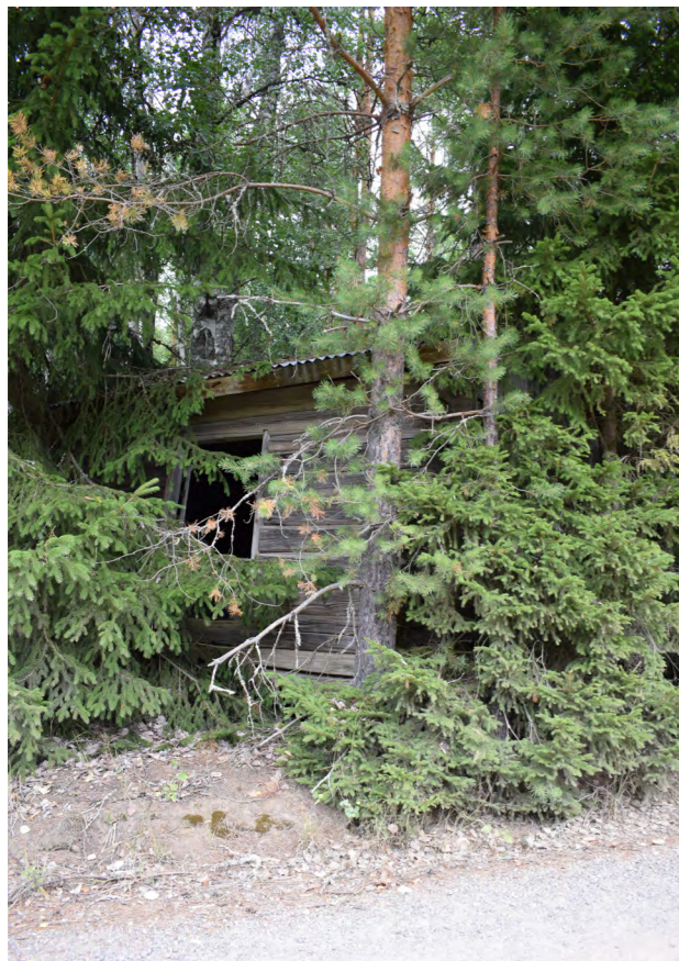
Kuva 347. Aitta on vajonnut pohjoiselta reunaltaan ja jäänyt kasvaneiden puiden siimekseen. (Paavilainen, 2023)
