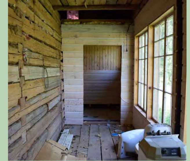
Kuva 394. Eteiseen on vuonna 2019 tehty useampi ikkuna-aukko ja tilan perälle on tehty märkätala. (Paavilainen, 2023)
