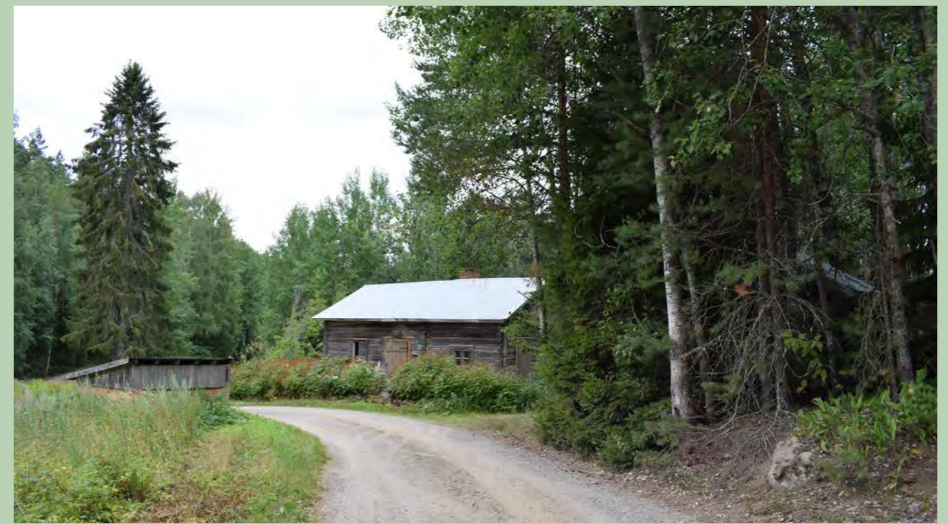
Kuva 349. Navetta, asuinrakennus ja aitta Myllyläntieltä. (Paavilainen, 2023)
