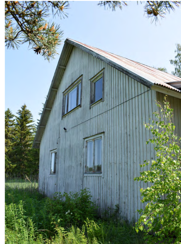
Kuva 418. Luoteisjulkisivu avautuu pellolle. (Paavilainen, 2023)
