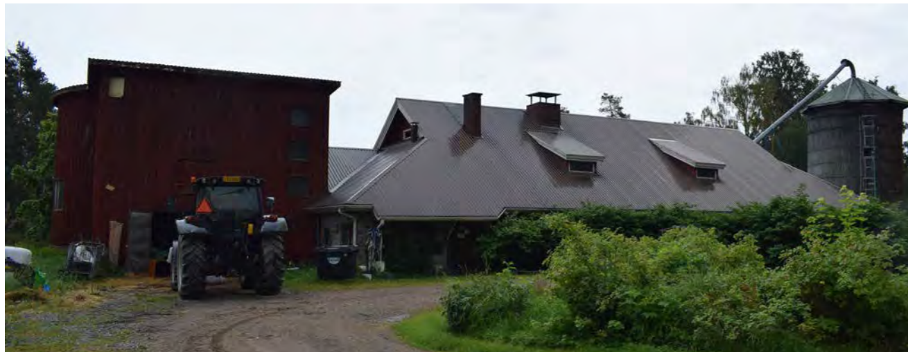
Kuva 41. Navetta on rakennettu 1920-luvun alussa. Puinen lisäosa on 1960-luvulta, ja rehotorni 1990-luvulta. (Paavilainen, 2023)
