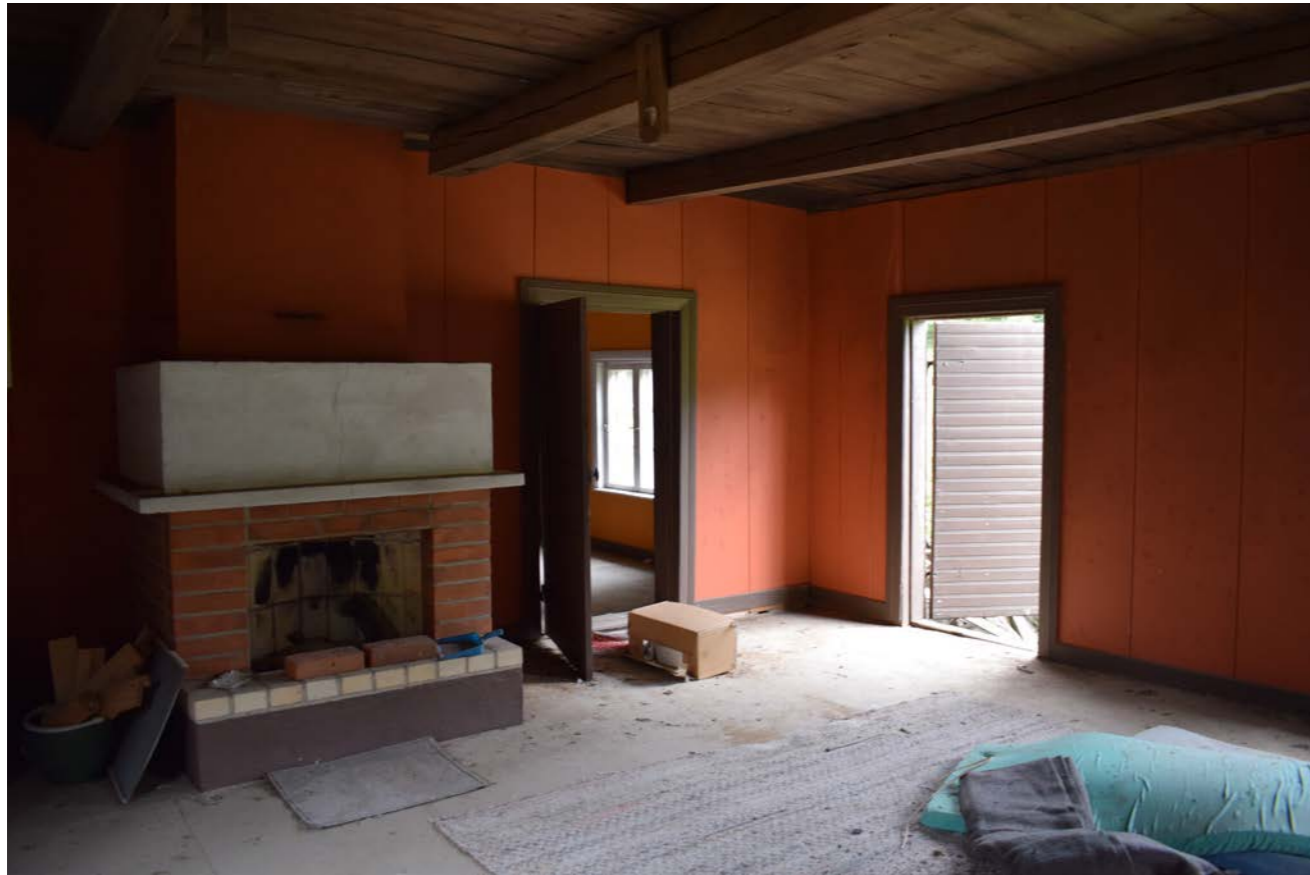
Kuva 342. Tuvassa on 1970-luvun peruskorjauksen myötä muovimatto, oranssit puukuitulevyt seinissä ja moderni tiilitakka. (Paavilainen, 2023)
