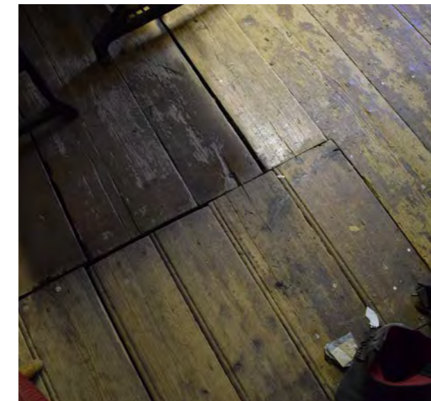
Kuva 76. Lattialaudoissa oleva sauma paljastaa entisen uunin koon ja paikan tuvan nurkassa. (Paavilainen, 2023)
