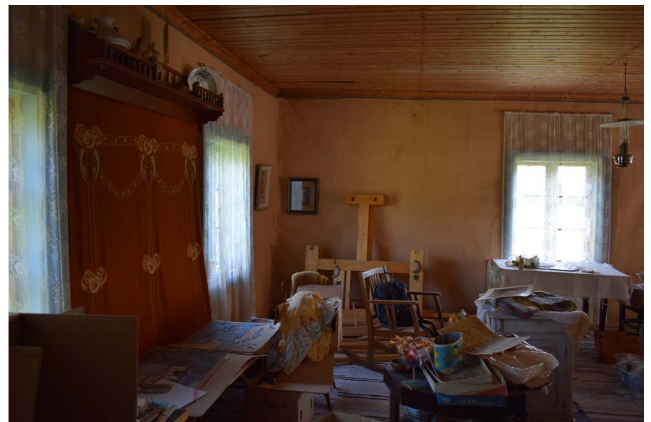
Kuva 254. Salissa on paneelikatto, seinissä oranssi pinkopahvi, ja lattiassa leveät lankut räsymattojen alla. (Paavilainen, 2023)
