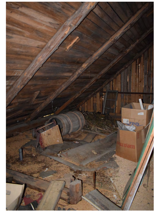
Kuva 440. Toinen eristämätön ullakko. (Paavilainen, 2023)
