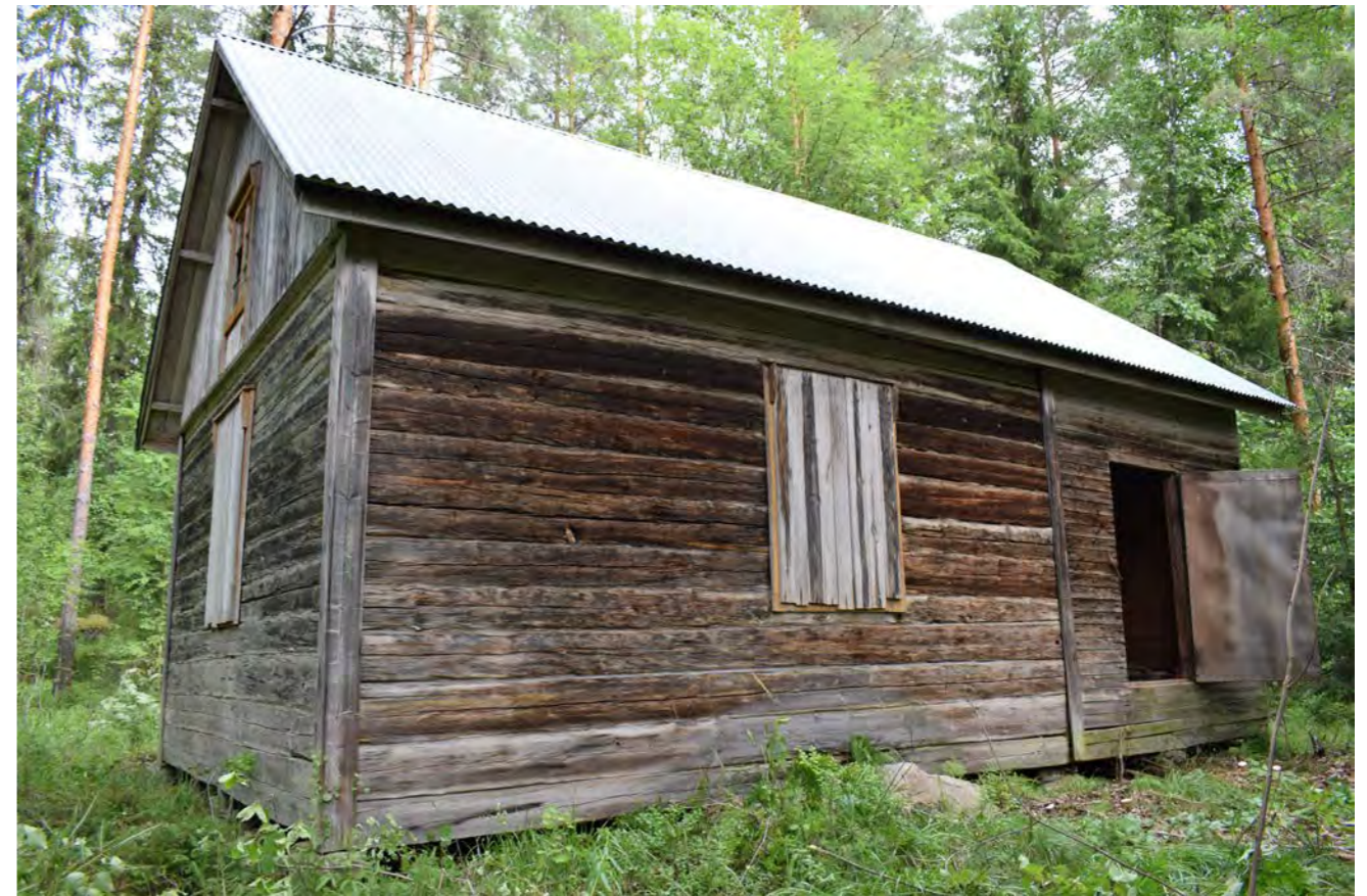
Kuva 358. Rakennus lounaasta. Aurinko on päässyt jonkin verran paahtamaan hirsiiä. Ympäröivät puut ovat suojanneet pahimmalta paahteelta. (Paavilainen, 2023)
