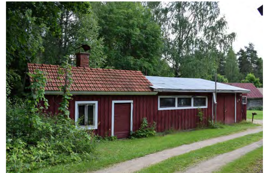
Kuva 110. Vanhan saunan päätyyn on 1980-luvulla rakennettu työhuone. (Paavilainen, 2023)
