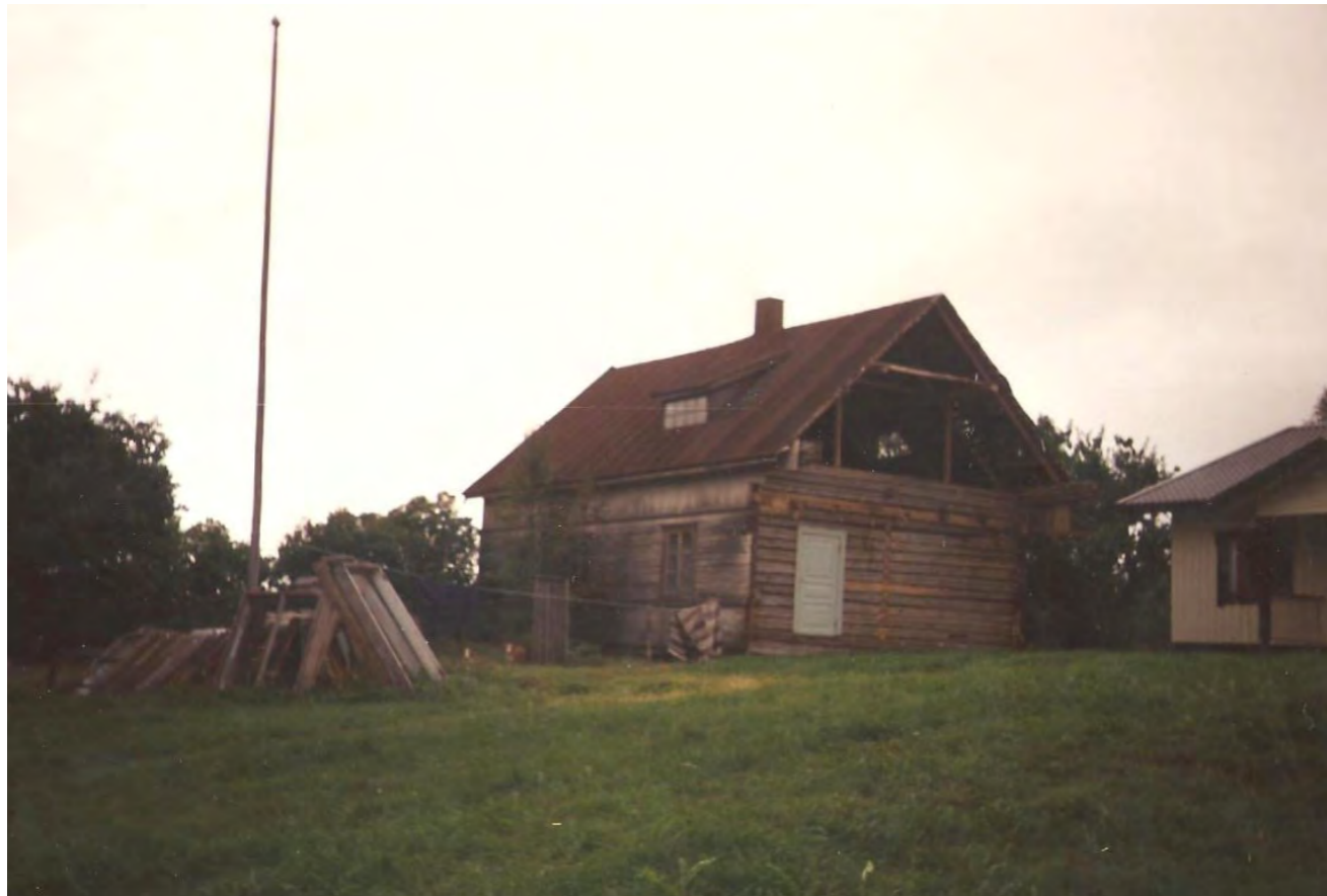
Kuva 239. Purku on loppunut. Jäljelle jäänyt osa rakennuksesta syyskuussa 1989. (Kuva Simolan omistajalta.)
