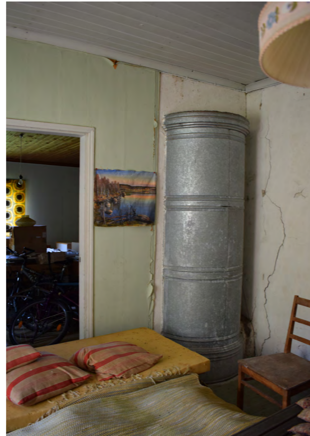
Kuva 430. Kamarin ja pirtin huoneen väliin rakennettu pönttöuuni. (Paavilainen, 2023)
