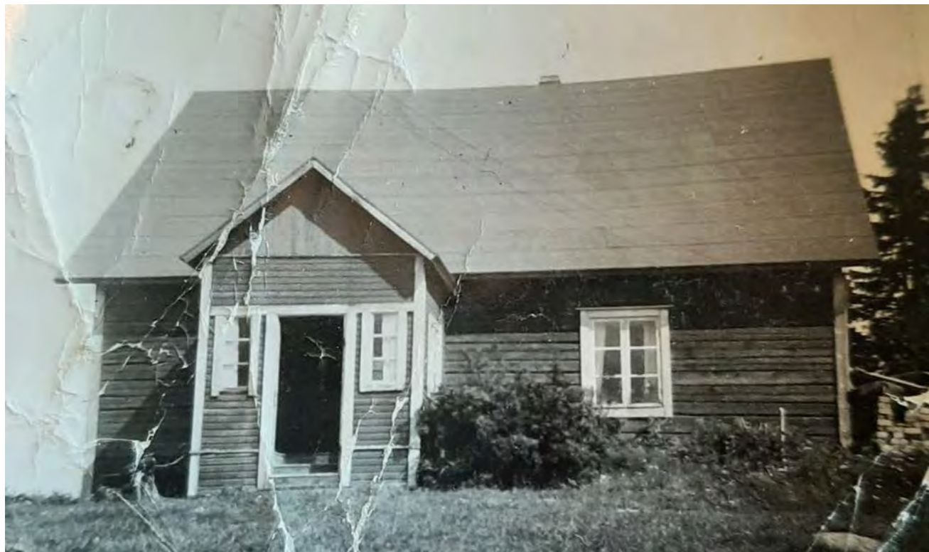
Kuva 130. Vuonna 1931 rakennetussa talossa oli alkujaan pienempi, satulakattoinen ja symmetrinen kuisti. Katto ollut aikaisemmin huopaa ja ulkoseinät vuoraamattomat. Valokuva otettu sota-ajan jälkeen. (Kuva Hailun omistajalta.)
