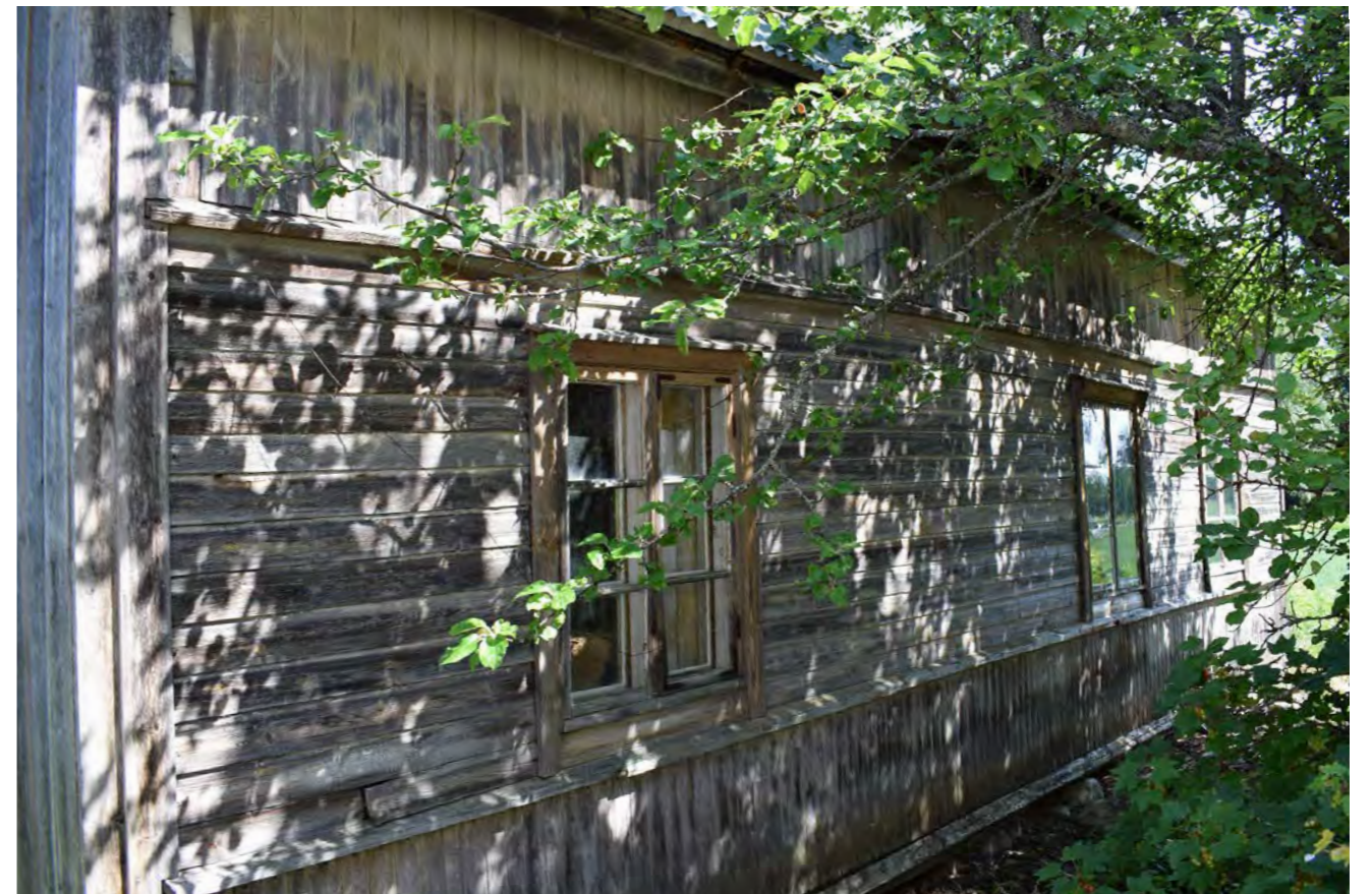
Kuva 247. Lounainen julkisivu on puiden varjossa. (Paavilainen, 2023)
