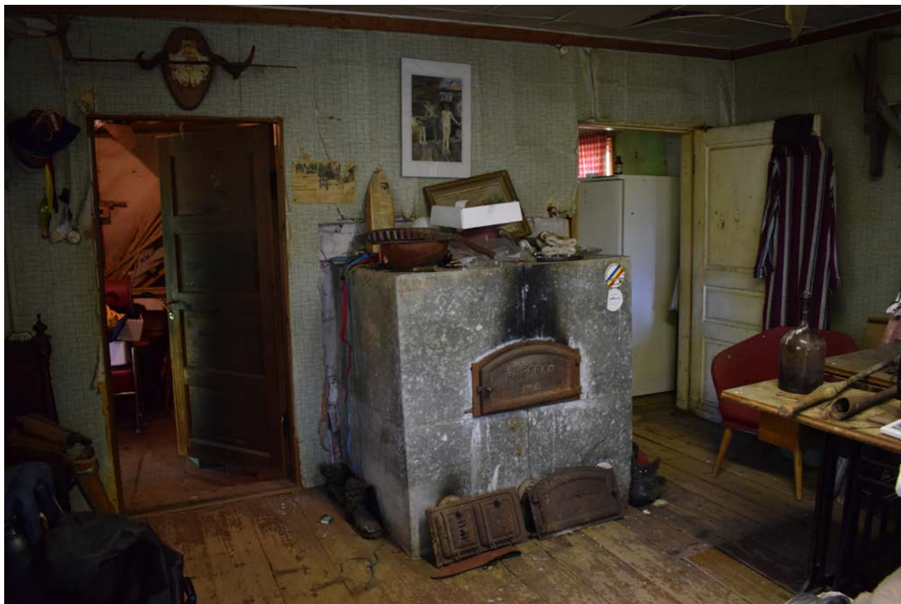
Kuva 74. Tuvan 1950-luvulla rakennettu leivinuuni. Uuni sijaitsi aikaisemmin tuvan nurkassa. Uuni purettiin ja uusi rakennettiin huoneen keskelle. Näin tuvasta saatiin oviaukko suoraan keittiöön. (Paavilainen, 2023)
