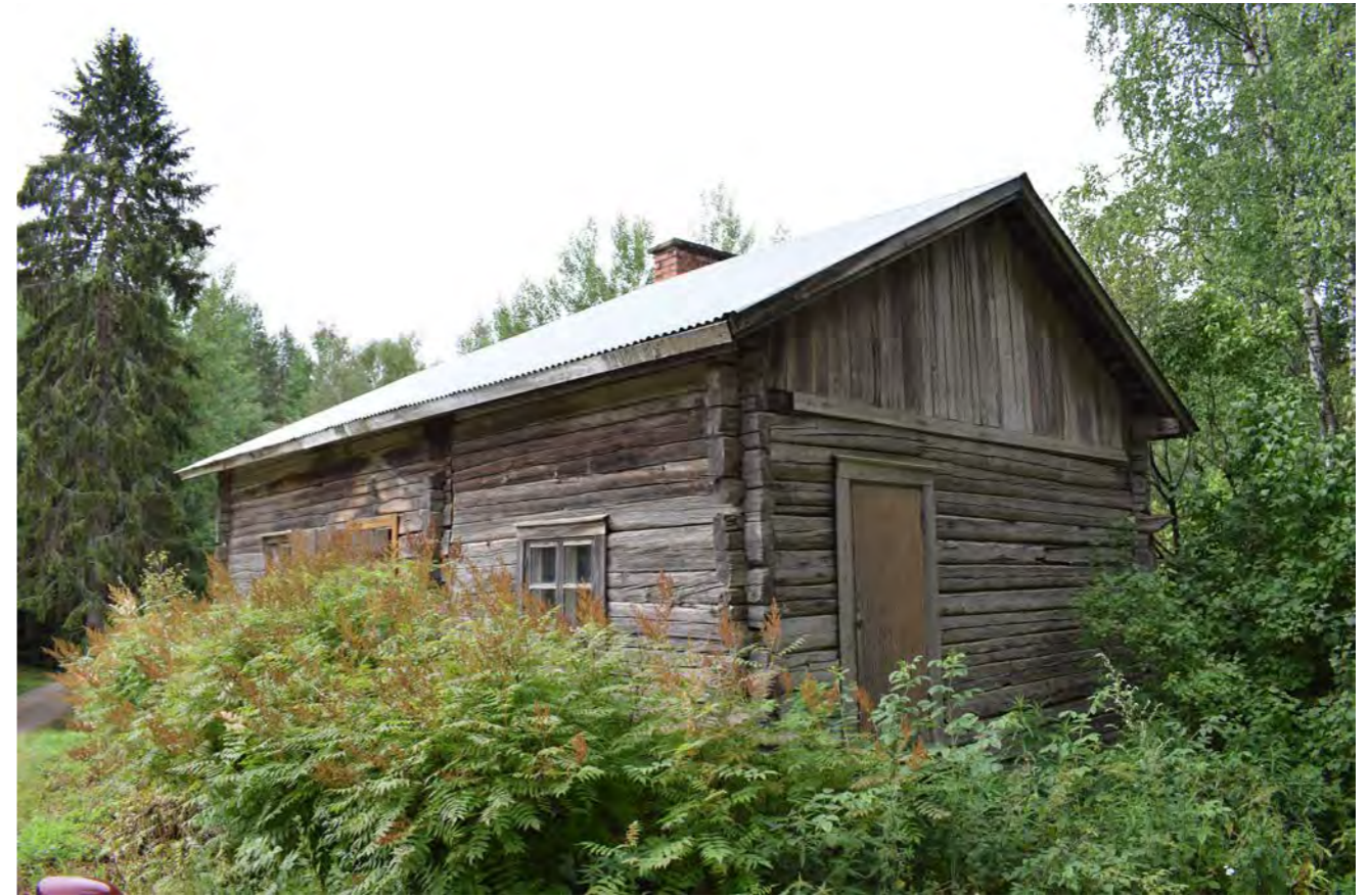
Kuva 339. Asuinrakennus koillisesta. Rakennuksessa on kaksi sisäänkäyntiä. Toinen ulko-ovi on rakennuksen päädysssä, toinen pitkällä sivulla. (Paavilainen, 2023)
