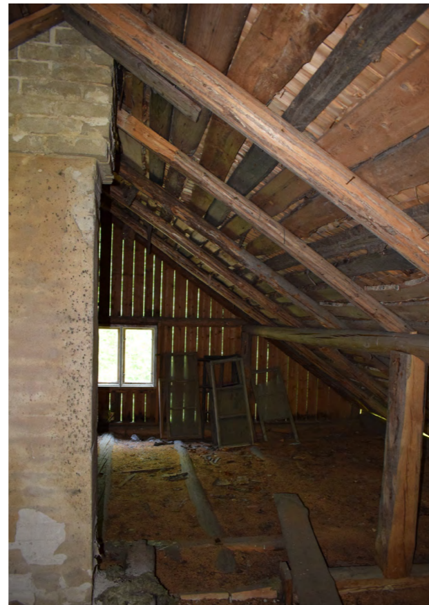
Kuva 170. Ullakko on eristämätöntä tilaa. (Paavilainen, 2023)
