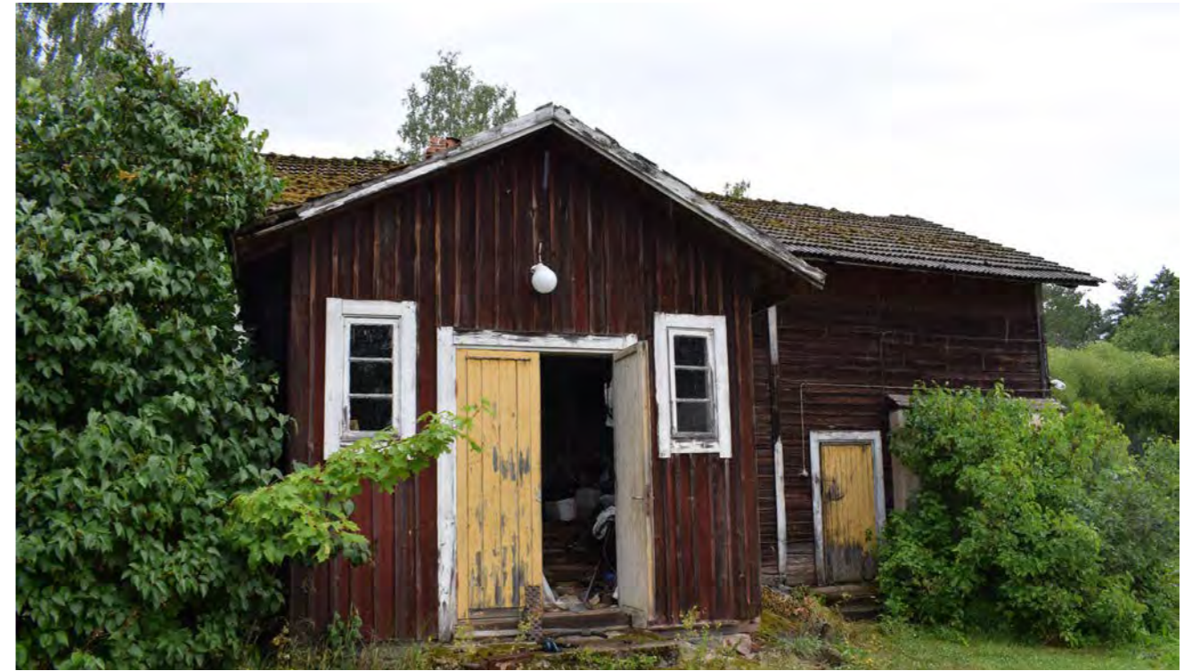
Kuva 28. Rakennuksen toinen kuisti, josta on kulku alkuperäiseen pirttiin ja keittiöön. Niiden jatkeena 1900-luvulla tehdyn laajennusosa, johon on käynti myös ulkoa. (Paavilainen, 2023)
