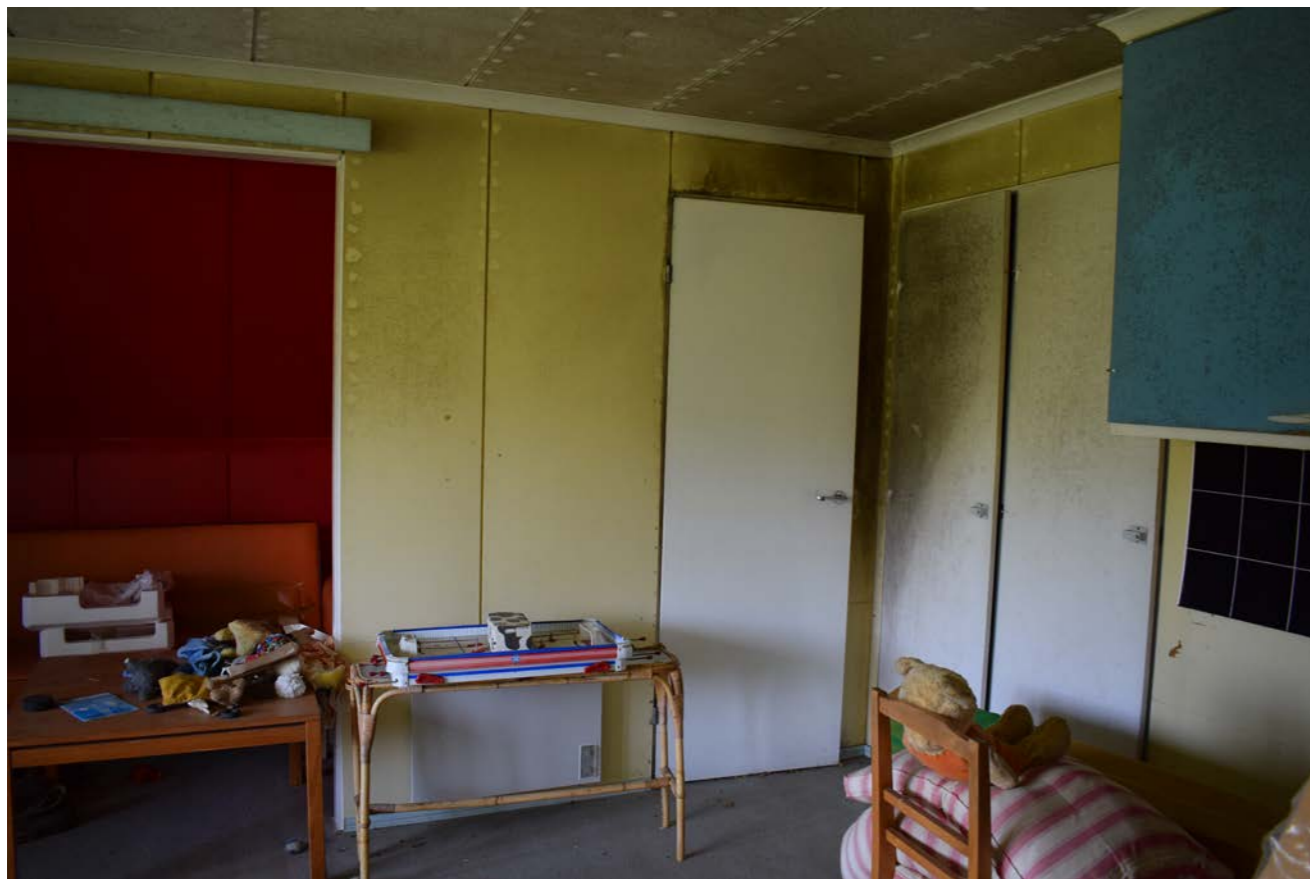
Kuva 437. Ensimmäisestä makuuhuoneesta on ovi eristämättömälle ullakolle sekä kaksi komeroa. (Paavilainen, 2023)
