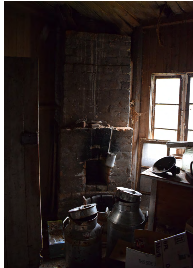
Kuva 32. Ruokavarastossa on myös uuni. Piippu on vuotanut ajan saatossa. (Paavilainen, 2023)
