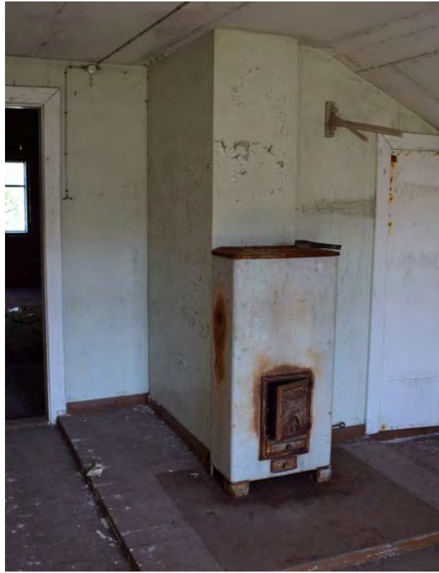
Kuva 313. Ullakkohuone on lämmitetty kamiinan avulla. Seinä ja katto on levytetty. (Paavilainen, 2023)
