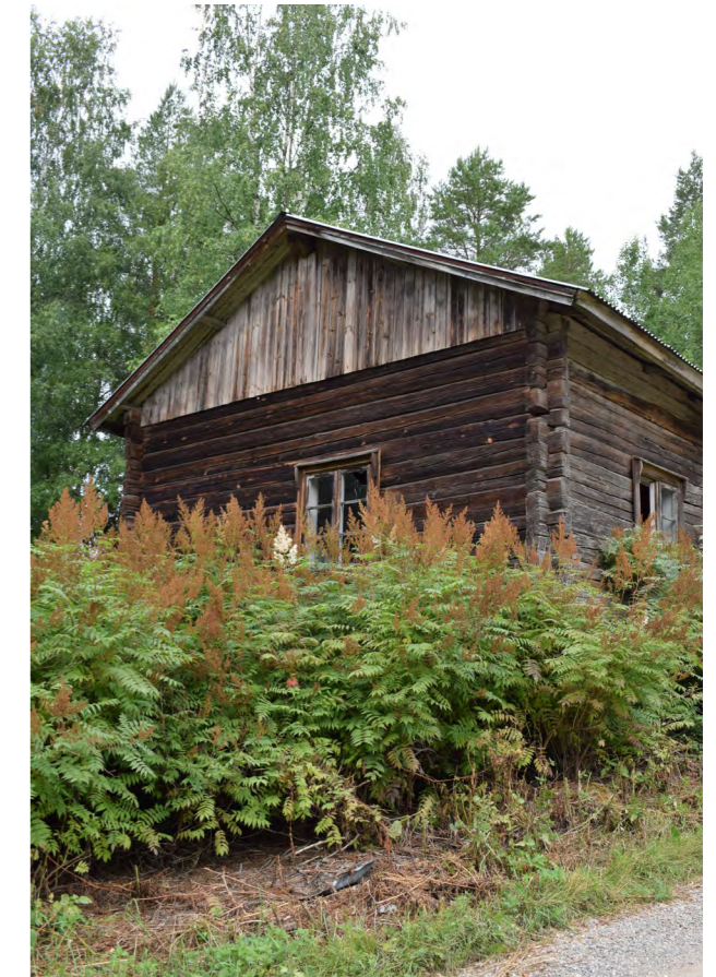
Kuva 341. Erityisesti etelän puolinen vuoraamaton julkisivu on tummunut auringossa. (Paavilainen, 2023)
