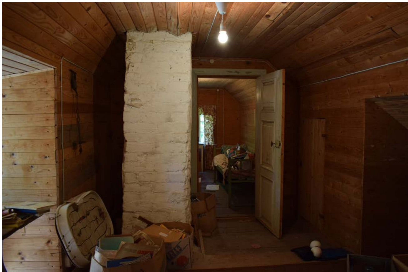
Kuva 55. Ullakon aula. (Paavilainen, 2023)
