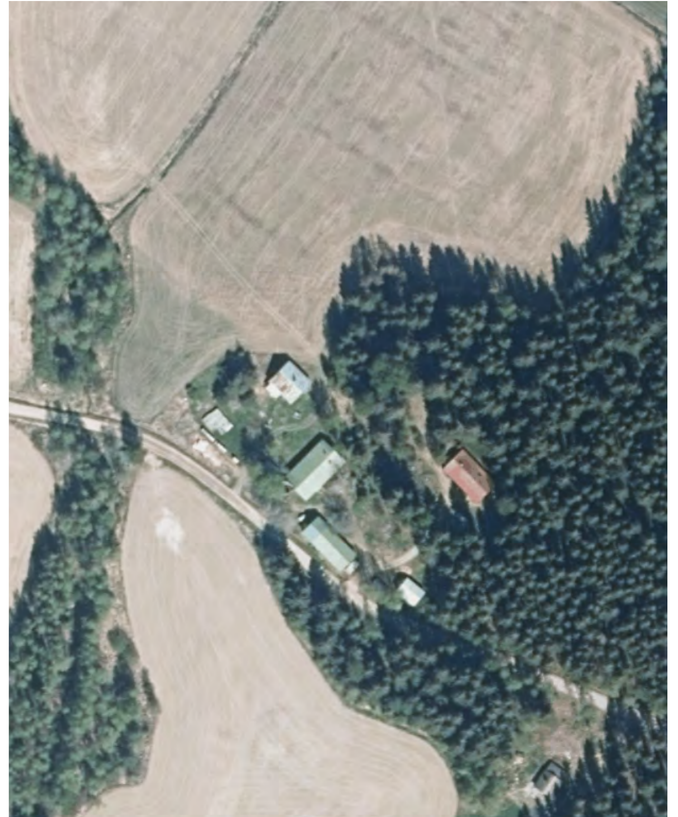
Kuva 445. Ilmakuva vuodelta 2022. Vanha navetta, savusauna ja aitta on purettu ja pihapiiriin on rakennettu uusi navetta sekä toinen asuinrakennus. Ajan saatossa on muodostunut kaksi pihapiiriä ja painopiste on siirtynyt uudemman asuinrakennuksen puolelle. (Maanmittauslaitos, 2024)
