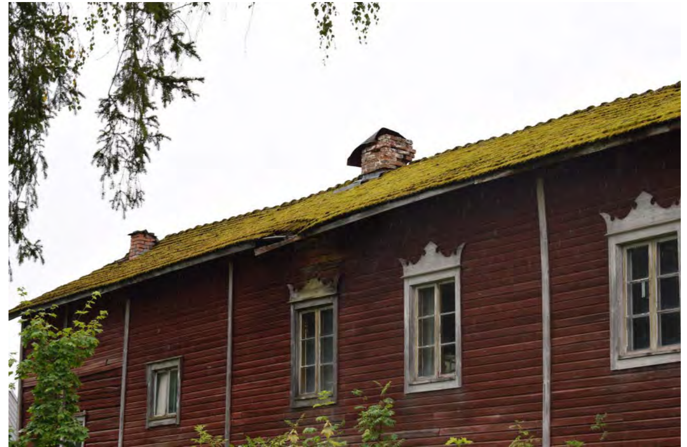
Kuva 38. Pahin vaurio katossa on pirtin kohdalla, johon puu kaatui. Painauma on havaittavissa ulkopuolelta. Savupiiput eivät myöskään ole hyvässä kunnossa. Katto on lisäksi hyvin sammaloitunut. (Paavilainen, 2023)
