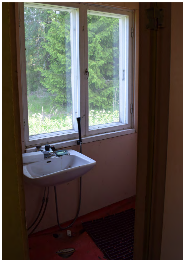
Kuva 431. Wc ja suihkuhuone. (Paavilainen, 2023)
