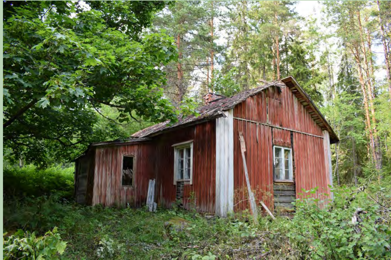
Kuva 192. Lintulan asuinrakennus. (Paavilainen, 2023)
