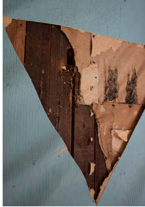
Kuva 224. Eteisessä pinkopahvin alta paljastui kerros pahvia ja lautaa hirren päällä. (Paavilainen, 2023)
