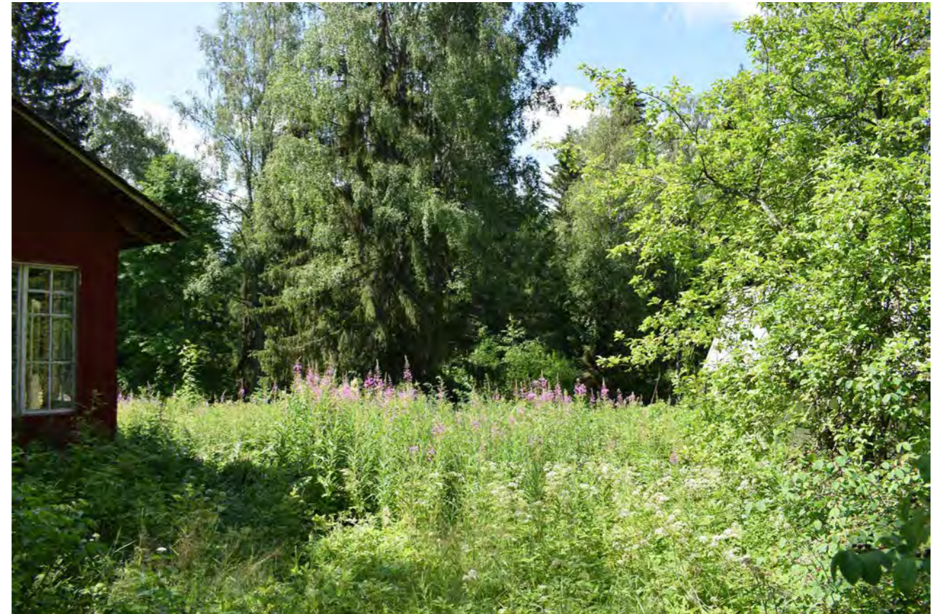
Kuva 387. Asuinrakennus vasemmalla ja navetan katto pilkistää oikealla. Pihamaa on kasvanut umpeen maitohorsmia ja vastaavia kasveja käytön puutteen myötä. (Paavilainen, 2023)
