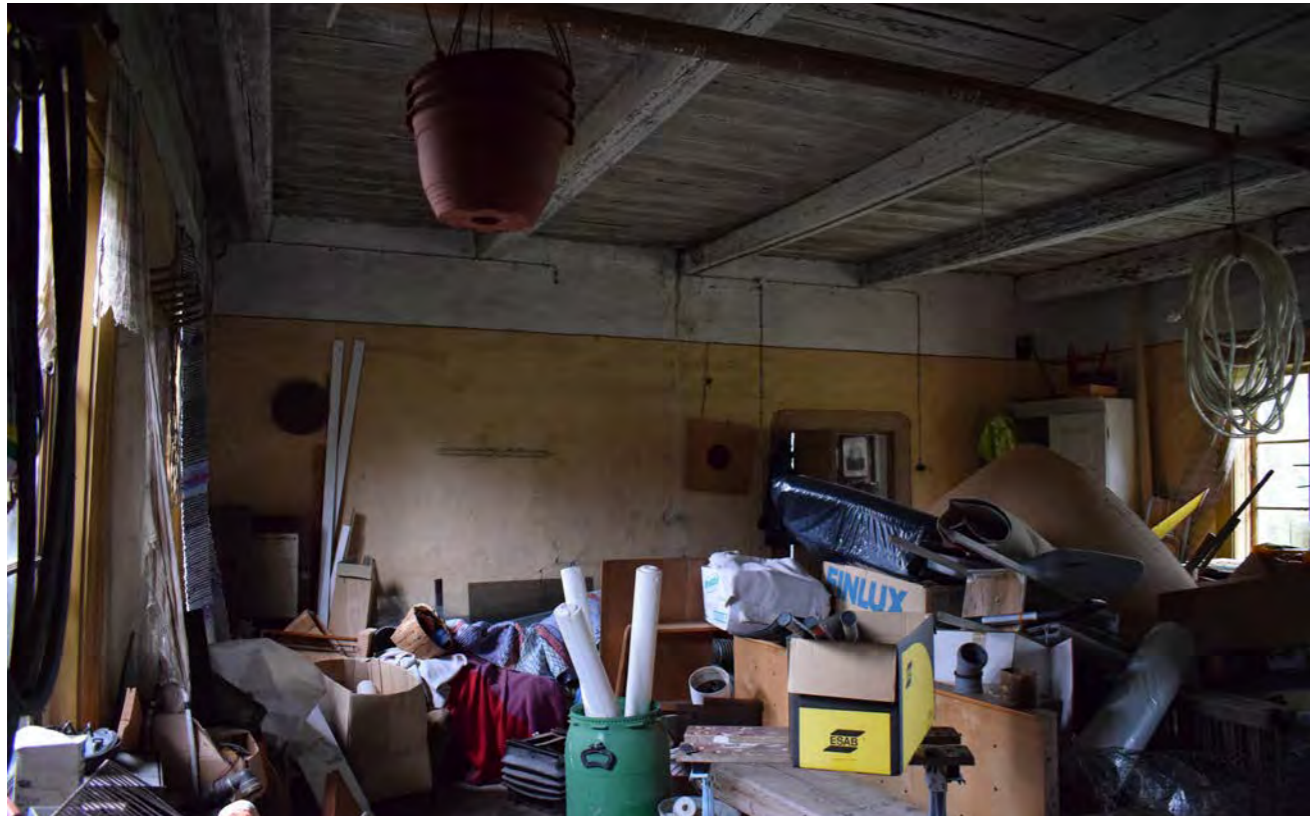
Kuva 30. Pirtissä on kalkkimaalattu katto, savirapatut ja maalatut seinät, sekä leveistä lankuista tehty lattia. Korkean huonekorkeuden myötä tila on varsin hieno. (Paavilainen, 2023)
