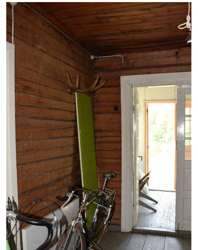
Kuva 139. Hirsipinta on jätetty näkyviin ainoastaan eteisessä. (Paavilainen, 2023)
