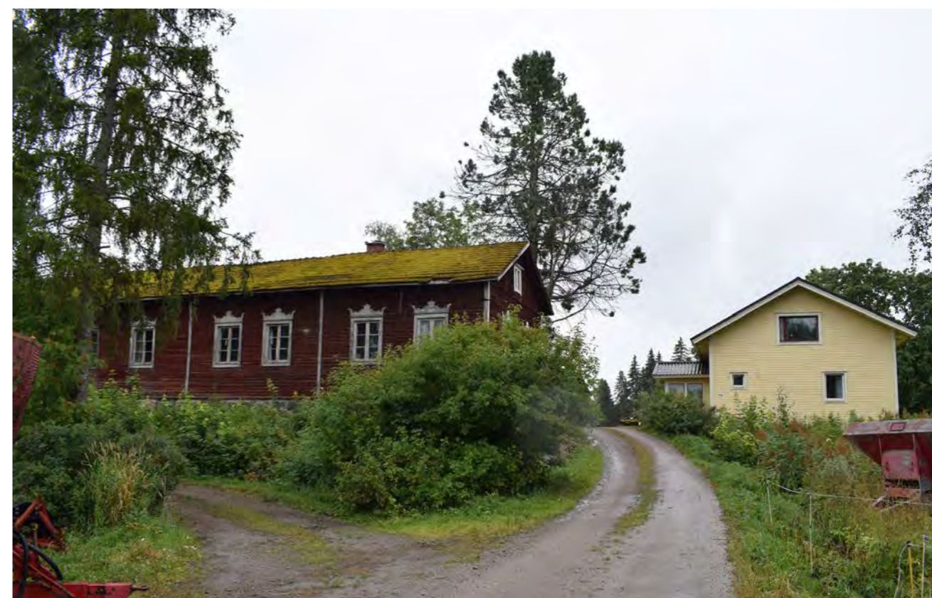
Kuva 26. Rakennukset samasta suunnasta kuin vanha valokuva aikaisemmalla aukeamalla. (Paavilainen, 2023)
