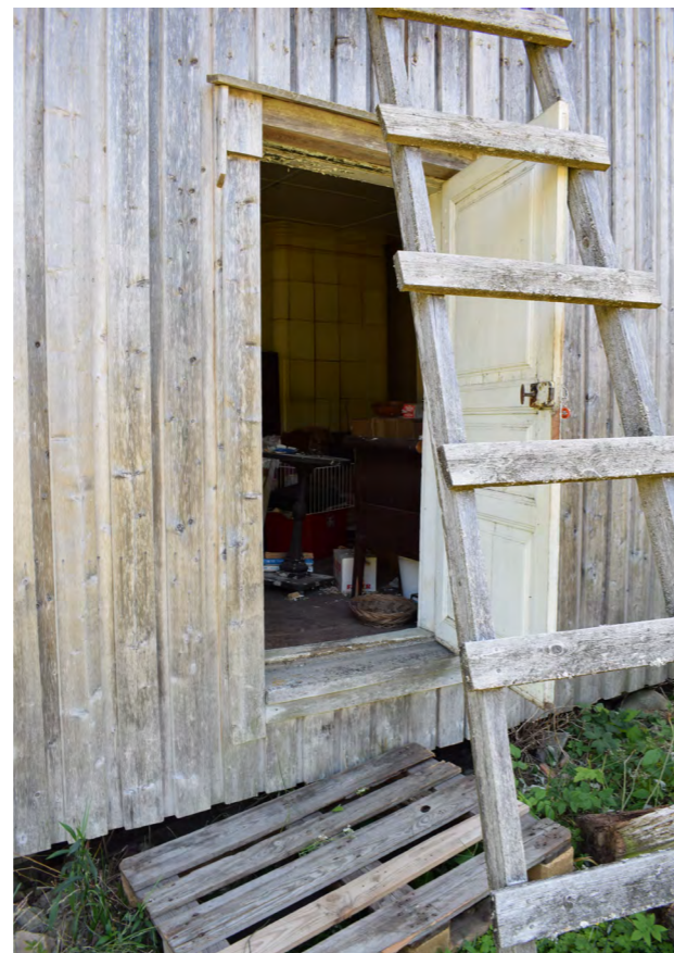
Kuva 246. Nykyinen ulko-ovi on ennen johtanut eteiseen. (Paavilainen, 2023)
