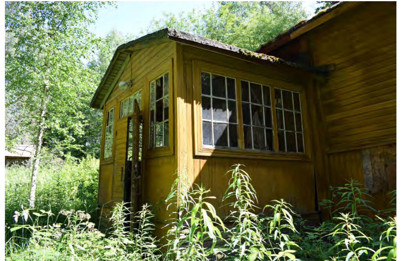
Kuva 71. Kuisti ja sisäänkäynti ovat rakennuksen luoteissivulla. (Paavilainen, 2023)
