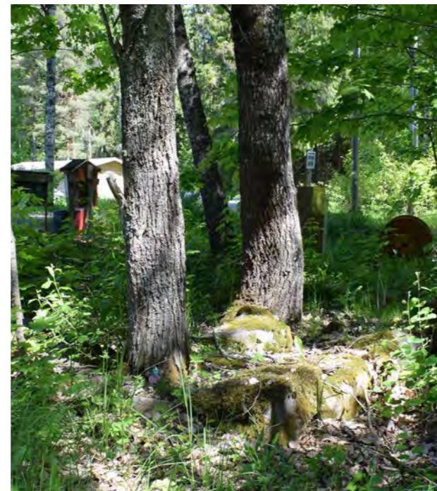
Kuva 61. Puuvajan perustukset. (Paavilainen, 2023)
