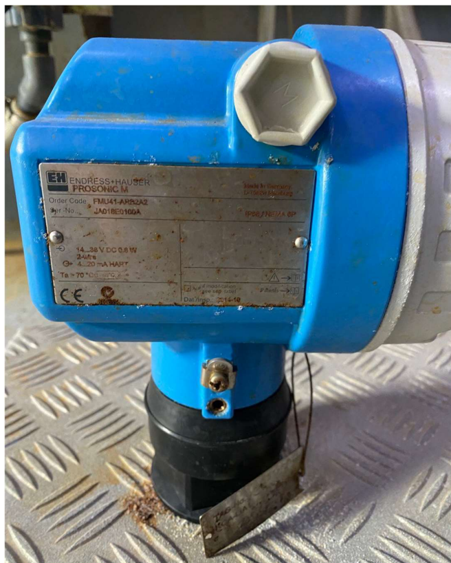
Kuva 8. Endress+Hauserin valmistama Prosonic M FMU41 pintamittari, jolla mitataan kemikaalisäiliön pinnan korkeutta.
