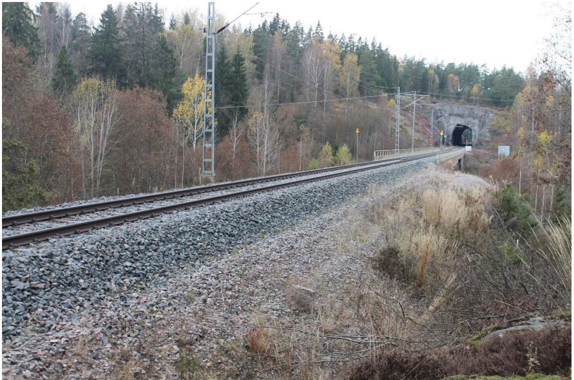
Kuva 3. Pengerretty rakenne (Kuula 2015).
