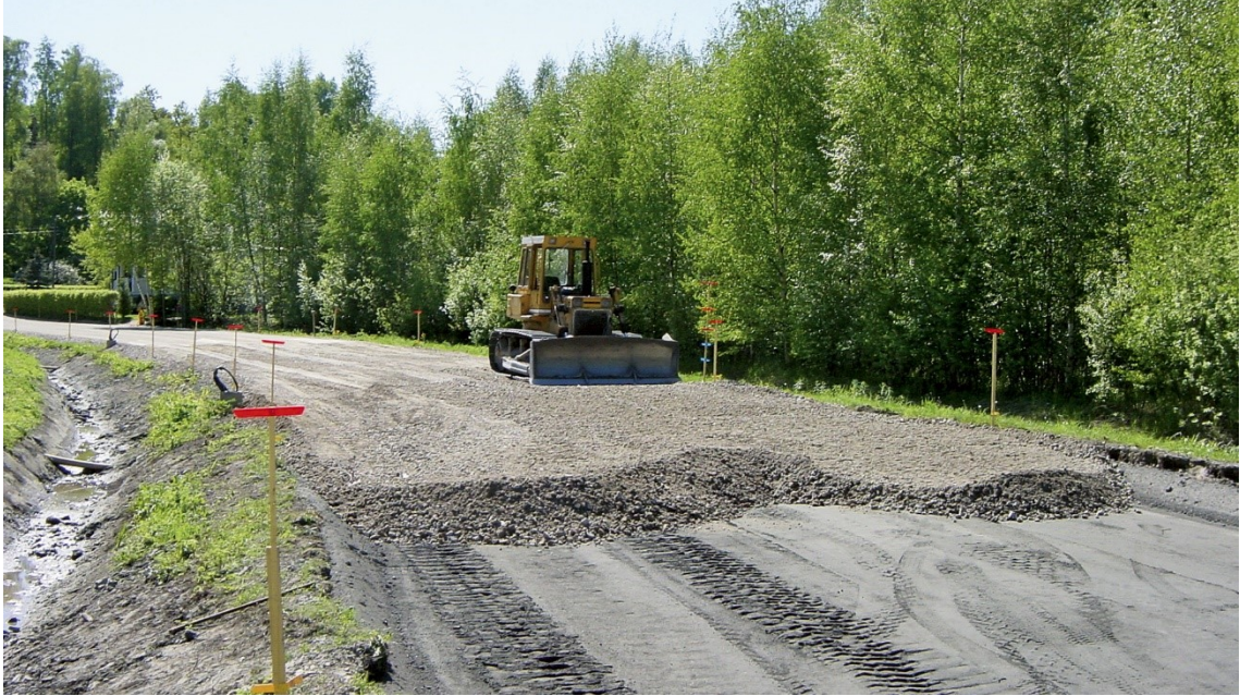
Kuva 9. Betonimurskeen levitystä tierakenteeseen. (Kunnas 2023)
