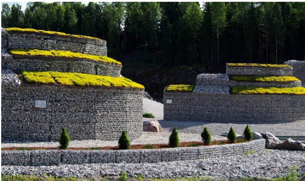
Kuva 5. Ruduksen Vantaan Länsisalmen toimipisteen sisäänkäynnin kivikorit on täytetty betonimurskeella. (Rudus 2016)
