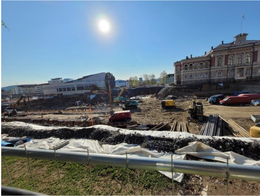
Kuva 10. Kirkkopuiston paraatiaukion työt etenevät 15.5.2023
