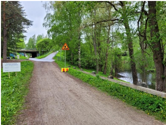
Kuva 17. Tourujoen kunnostus osittain aloitettu 26.5.2023
