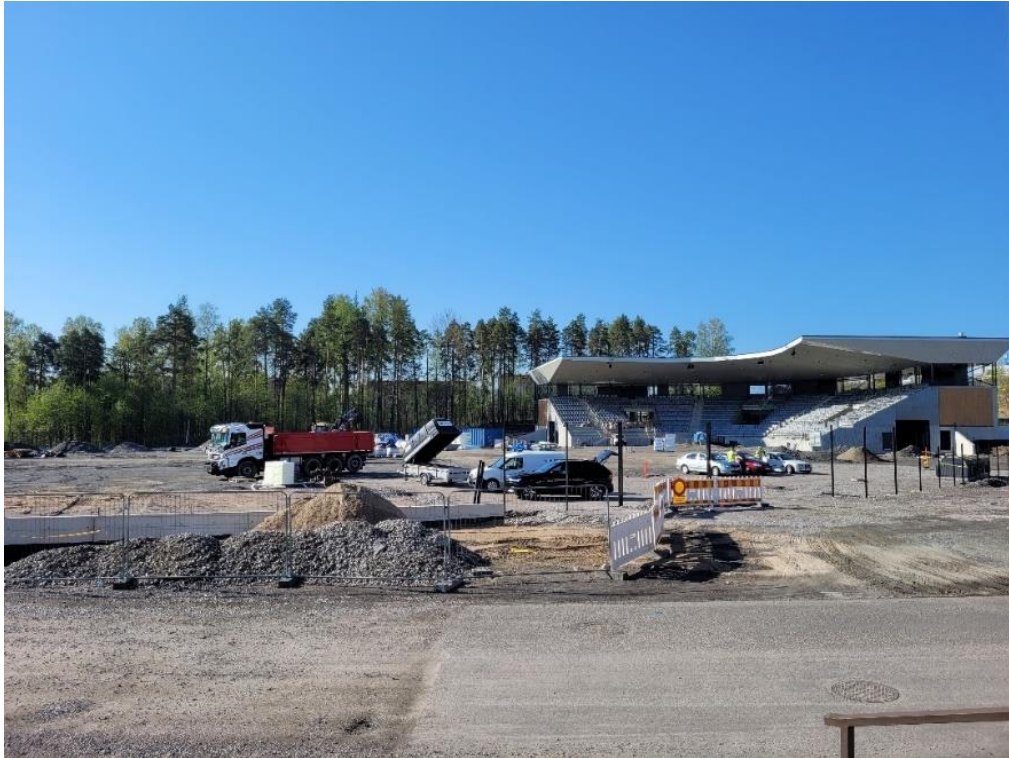
Kuva 13. Pesäpallostadionin rakentaminen käynnissä 15.5.2023
