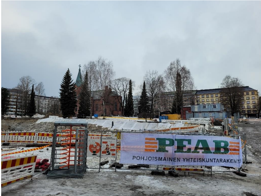
Kuva 8. Kirkkopuiston paraatiauکیo kaivettuna auki 23.3.2023
