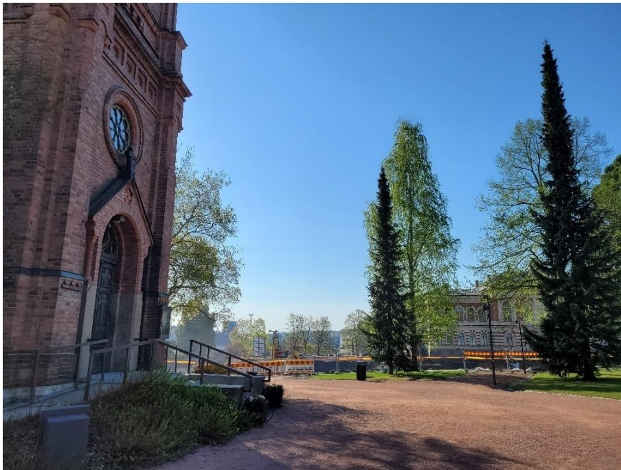
Kuva 9. Kaupungin kirkko ja kaupungintalo, työmaa-alue aidattuna 15.5.2023
