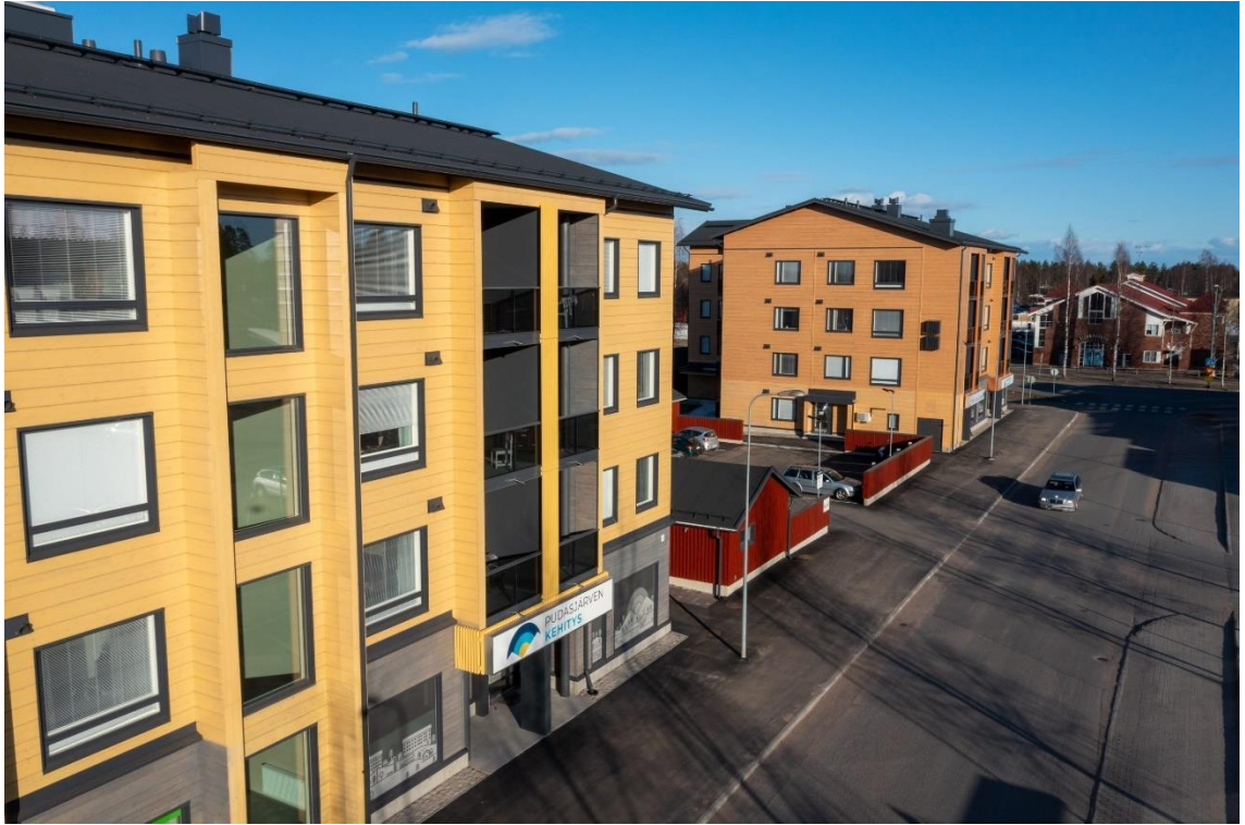
Kuva 3. Hirsihovin julkisivu. (Puuinfo 2022)
