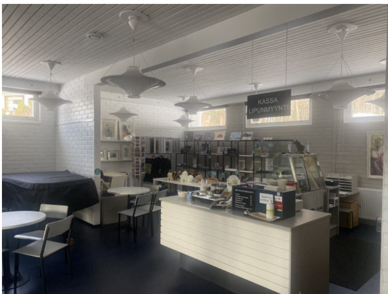
Kuva 20: Entisen kerhuhuoneen ja aulan välistä väliseinää purettiin, jotta uutta kahvilaa saatiin laajennettua.
