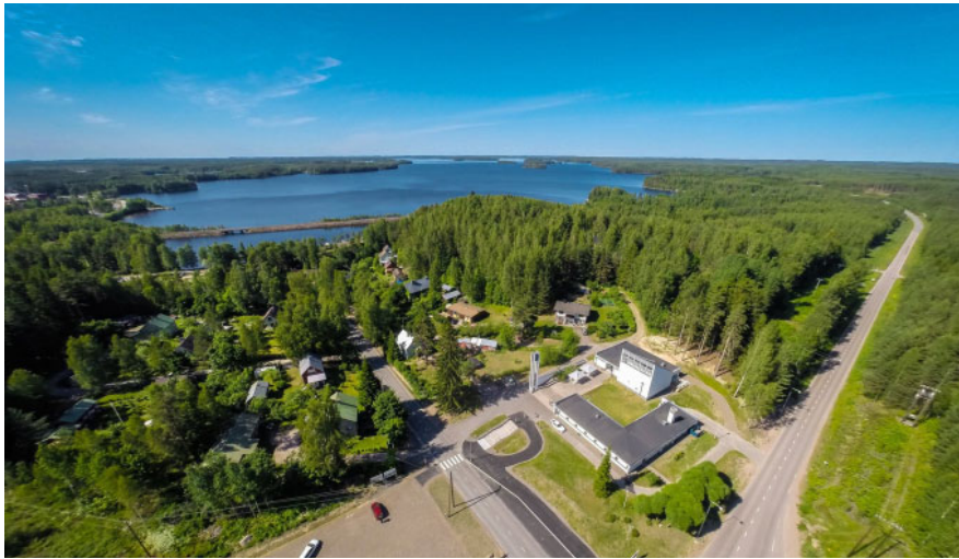
Kuva 16: Vuohijärven kulttuuritalo sijaitsee risteyksessä Vuohijärven kylän keskustassa. (Rautiainen 2015)
