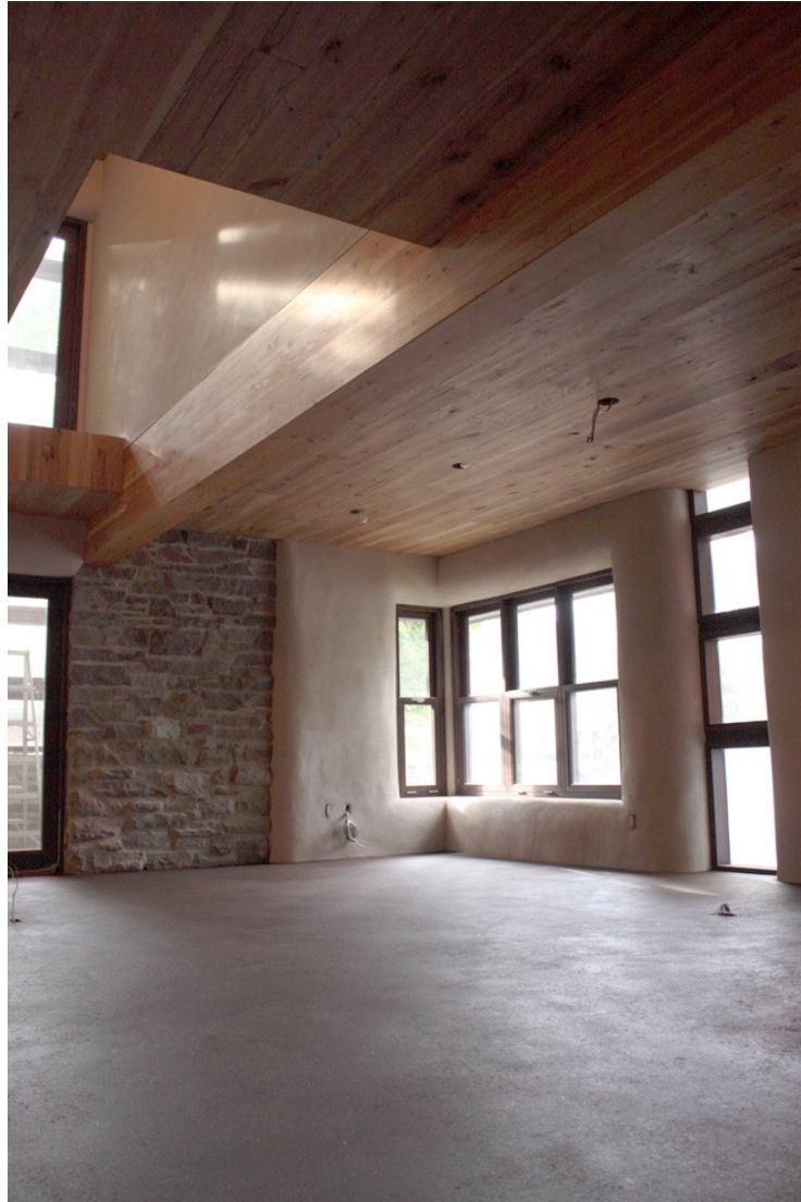
Kuva 6. Savea voi käyttää runko- ja rappausmateriaalina seinissä sekä lattiassa. (Henry 2013)
