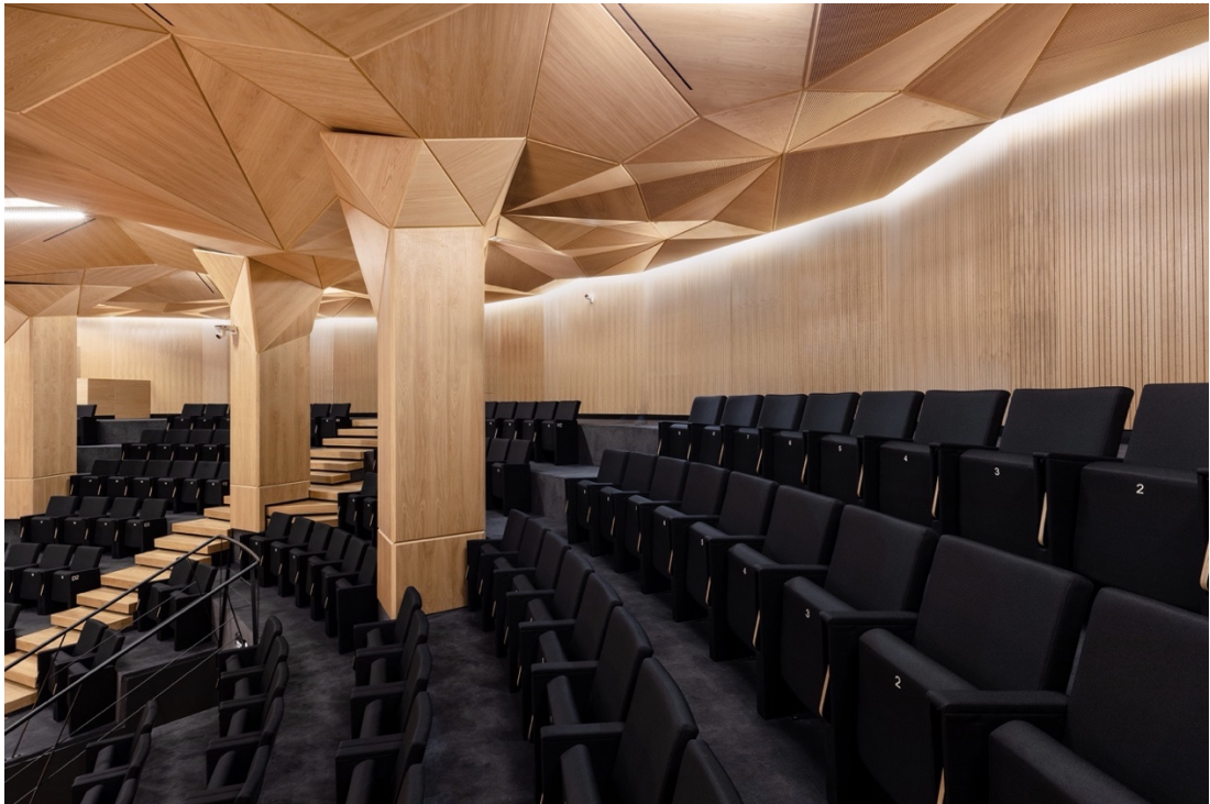
Kuva 11. Technopoliksen amfiteatteri. (ahylo architects 2020) Strukturoidut ja kaarevat pinnat hallitsevat sekä hajottavat ääniaaltoja (Mommertz 2011, Wood for well-being 2019 mukaan).
