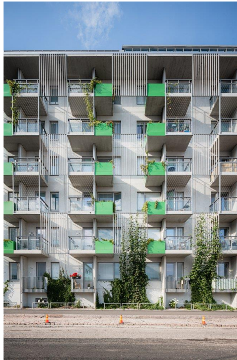
Kuva 10. Kuva Kalasataman asuinkerrostalon kaksoisjulkisivusta (Pyrö Kantonen 2017).
