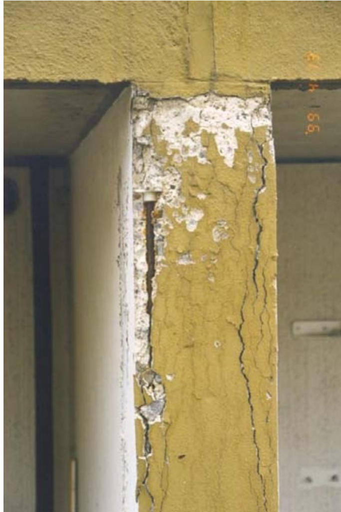
Kuva 2. Parvekkeen piellelementin rapautunut etureuna [11, s. 25]
