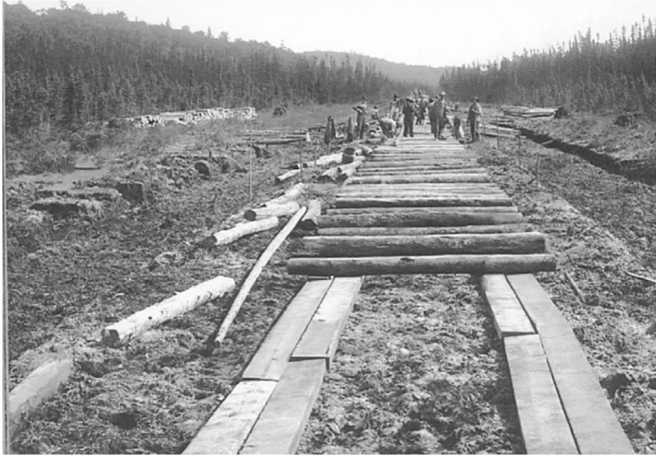
Kuva 19. Järeän hirsiarinan rakentamista turvepohjamaalle (MacFarlane 1969)
