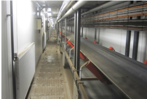
Umpisilta joka eristetty Paroc elementeillä
