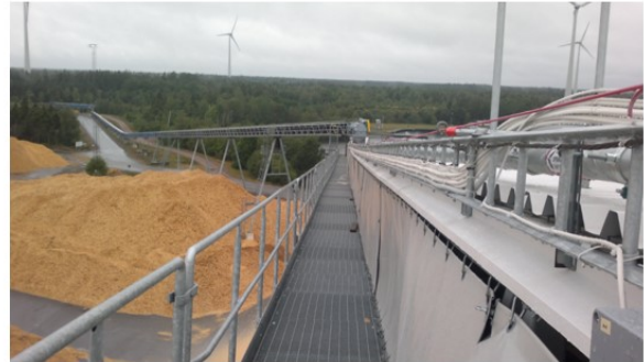
Avosilta joka varustettu pressuseinällä
