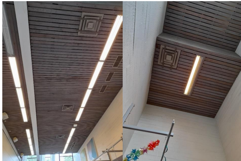
Kuvat 51 ja 52: Kohteen I ruokasalin kattorakenteita.
