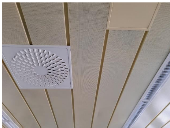
Kuva 46: Kohteen H ruokasalin alakattorakenne.
