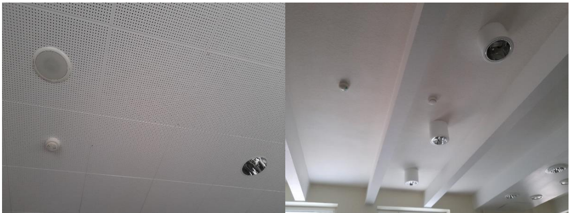
Kuvat 17 ja 18: Kohteen C ruokasalin alakattorakenteita.
