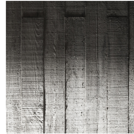
Kuva 19: Paikalla valettu betoni
