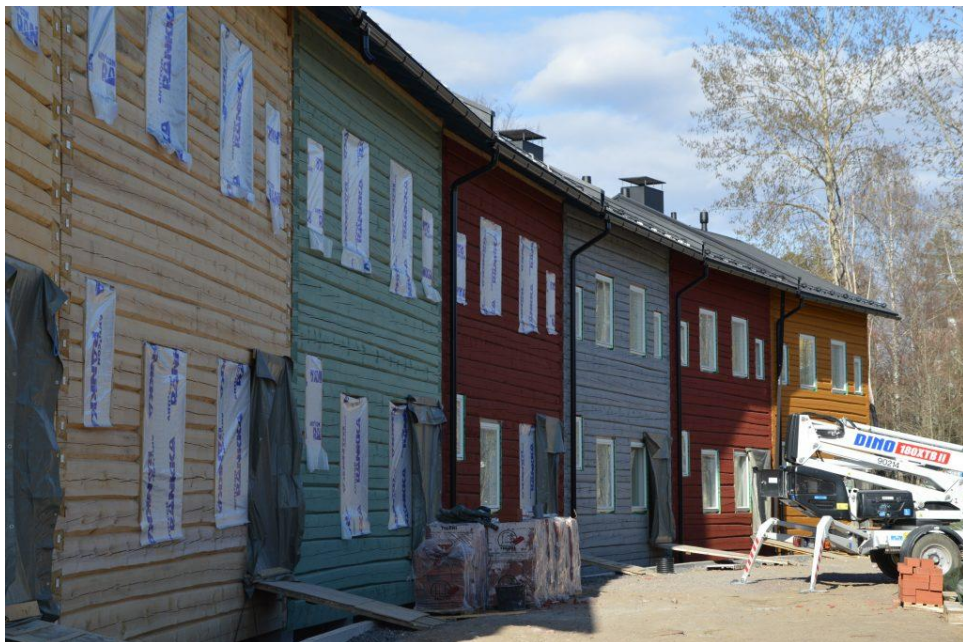
Kuva 1. Honkasuon aarraittojen julkisivut. Asemakaavamääräyksen mukainen erivärisyys saatiin aikaan erivärisillä keittomaaleilla. (Puuinfo 2022b)
