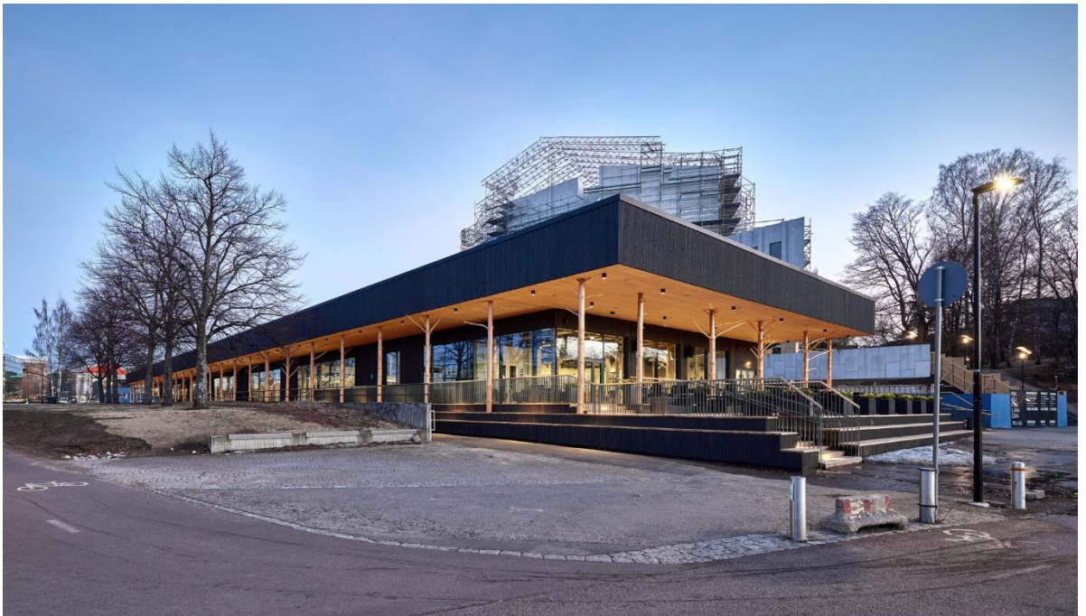
Kuva 2. Pikku-Finlandia. Taustalla Finlandia talon perusparannustyömaa. (ark 2022a)
