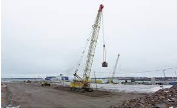
Kuva 12. Dynaamisessa syvätiivistyksessä maapohjaa tiivistetään aiheuttamalla raskaalla painolla impulssi maarakenteeseen (uuttahelsinkia 2015).
