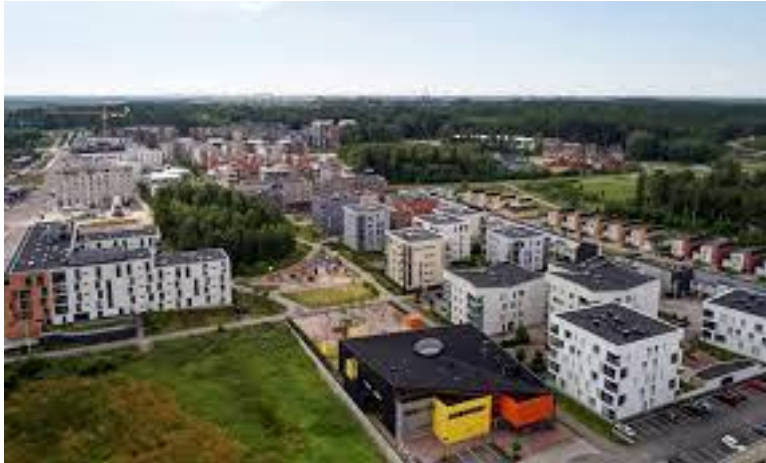
Kuva 1. Espoon Suurpellon asuinalue on rakennettu kokonaisuudessaan pehmeikön päälle ja alueelle onkin tehty mittavat pohjanvahvistustyöt (TA, 2019).
