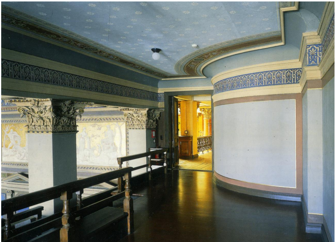
Kuva 24 Salin parven puulattia oli vuosikymmenten aikana osittain purettu, mutta se palautettiin 1990-luvun alussa valmistuneessa korjauksessa. (Helander et al. 1999, 96. Valokuvaus Simo Rista.)
