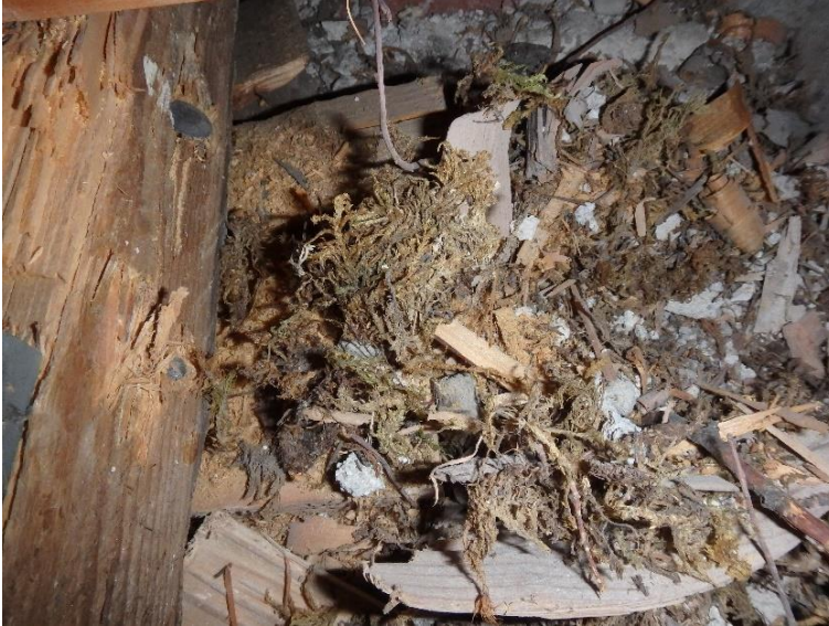
Kuva 29 Välipohjatäytteenä on käytetty monipuolisesti saatavilla olevaa materiaalia (Mehto 2021 b)
