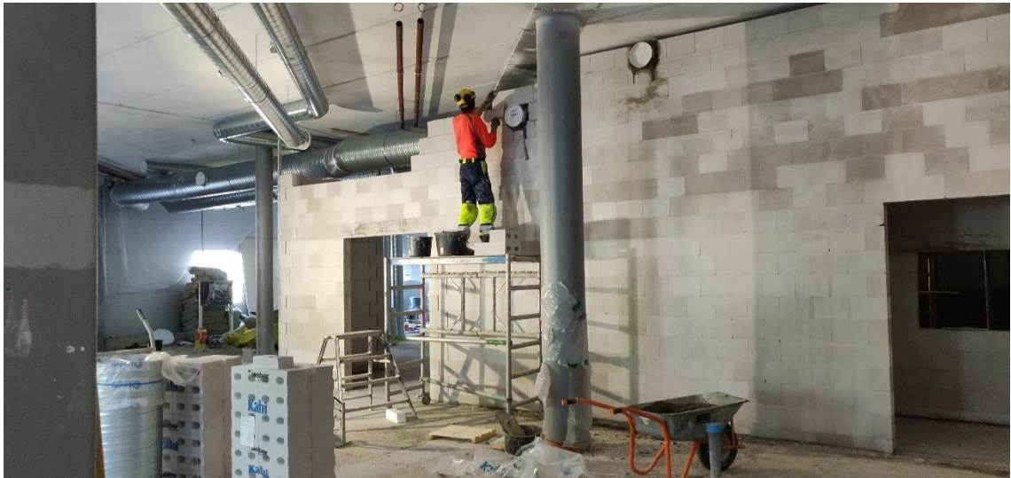
Kuva 3: Hallirakennuksen väliseinän muurausta (Kaakinen 2020).
