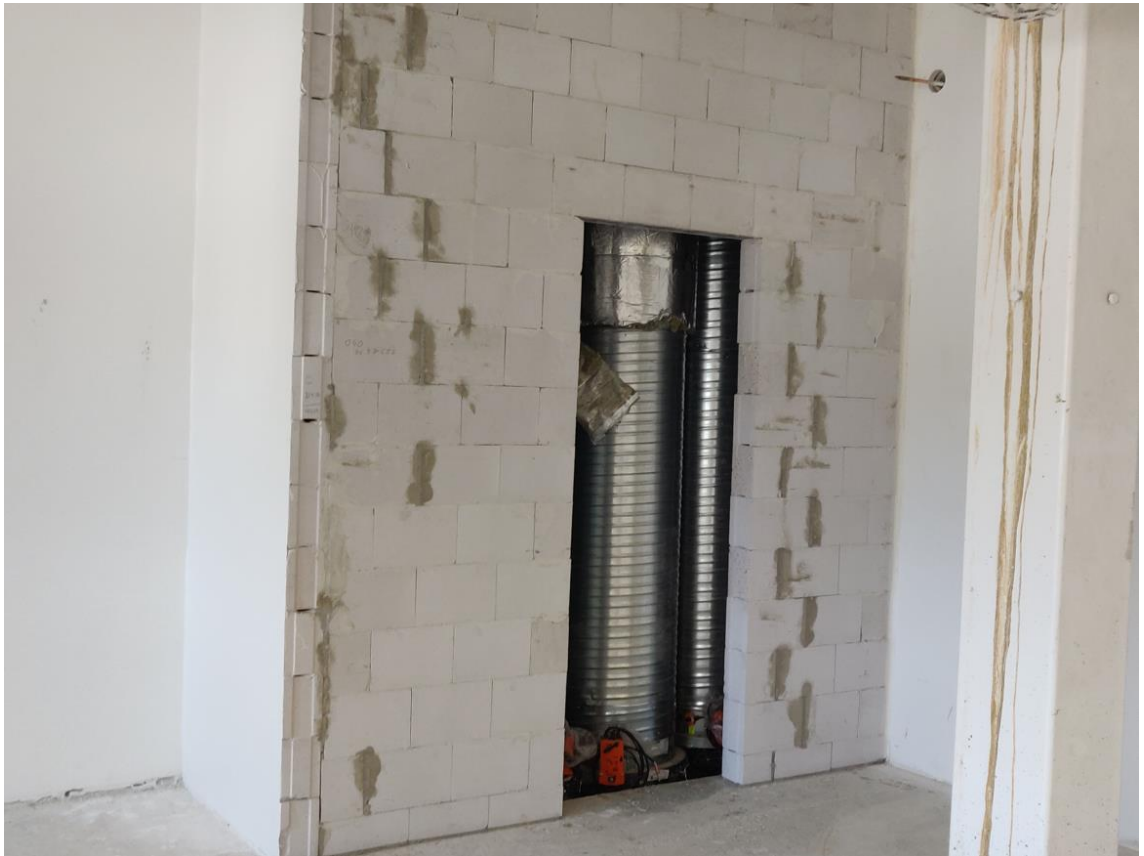
Kuva 1: Muurattu talotekniikkakuilun väliseinä tehdasrakennuksessa (Kaakinen 2021)
