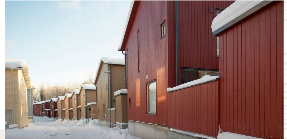
Kuva 23. Tikkurila Ultra - polyakrylaattimaalilla maalattu puujulkisivu. (Tikkurila 2022, C.)
