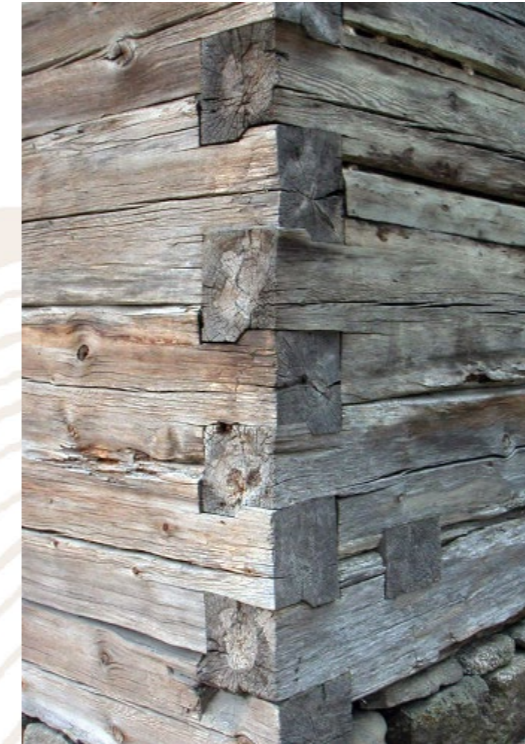
Kuva 31. Oikein rakennettuna hirsirakennukset kestävät ilman minkäänlaisia suojakäsittelyitä. (Puuproffa 2022.)
