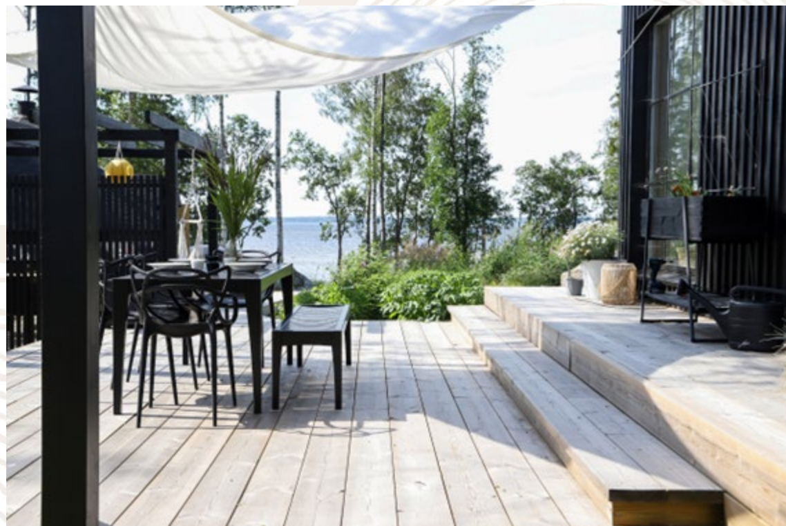
Kuva 11. Kestopuusta rakennettu terassi. (Kestopuuteollisuus Ry, 2022.)
