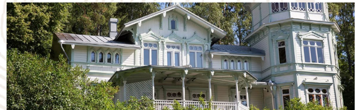
Kuva 24. Uula pellavaöljymaalilla maalattu puujulkisivu. (Uula Color Oy 2022, A.)
