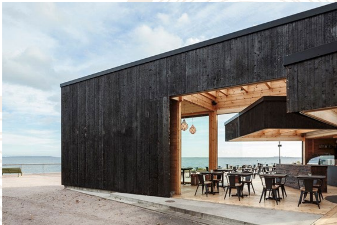
Kuva 22. Hiilletystä puusta valmistettu ulkoverhous Helsingin Hernesaareen rakennuksessa ravintola Birgitassa. (Puuinfo 2020, B.)
