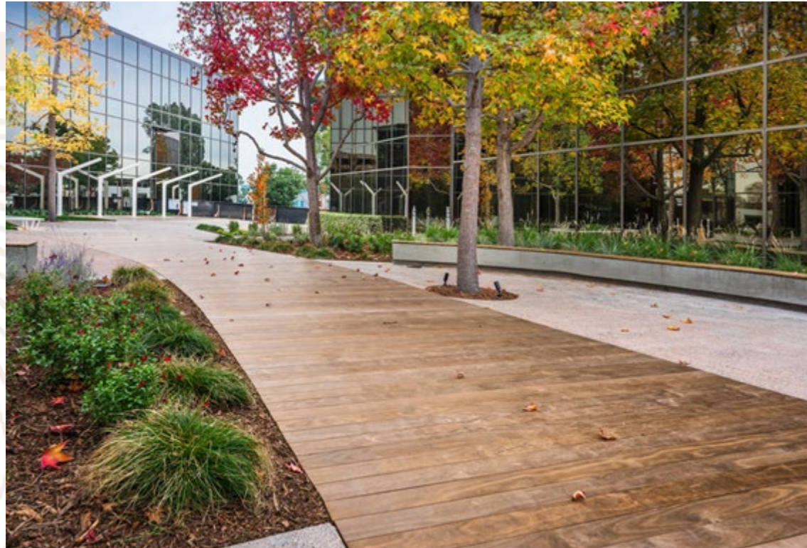
Kuva 20. Kebony® terassilaudoituksella toteutettu kävelykatu. (Kebony® 2022, B.)
