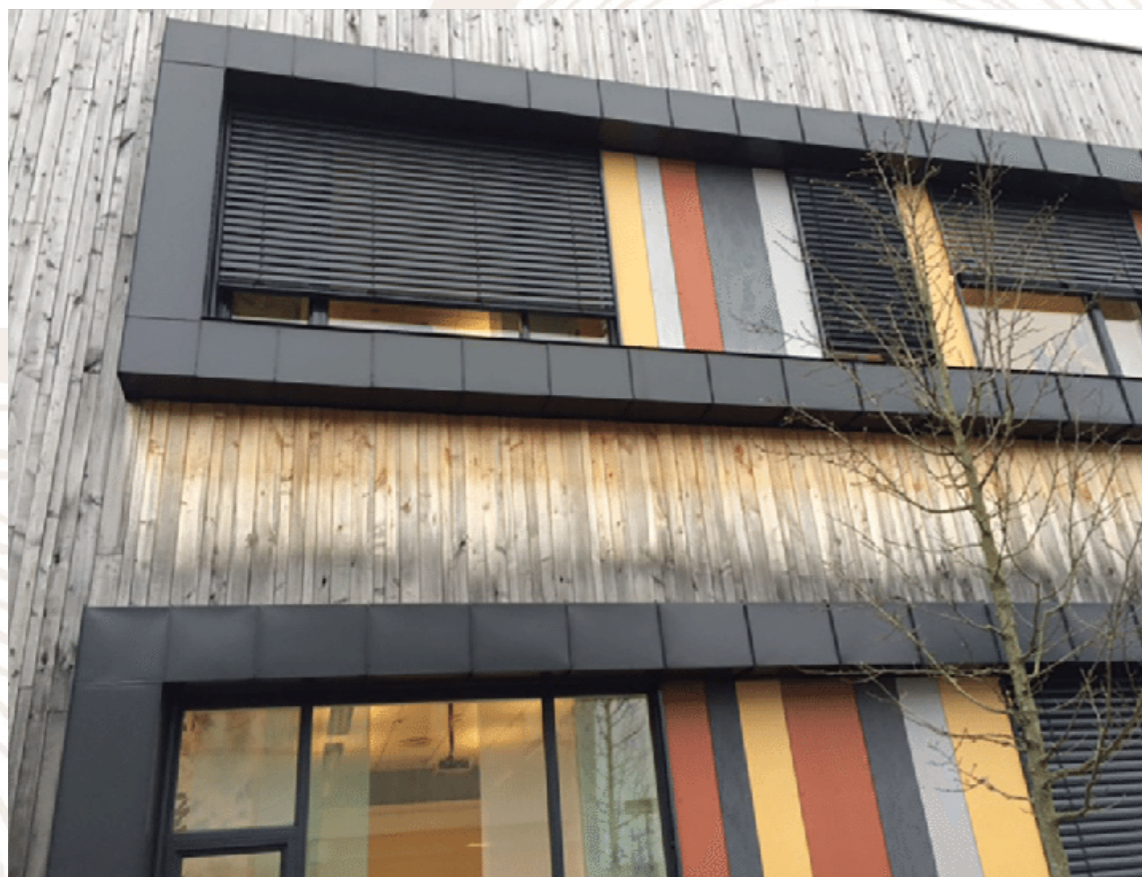
Kuva 7. Sään aiheuttamia epätasaisia muutoksia. (Smeland ym. 2016.)
