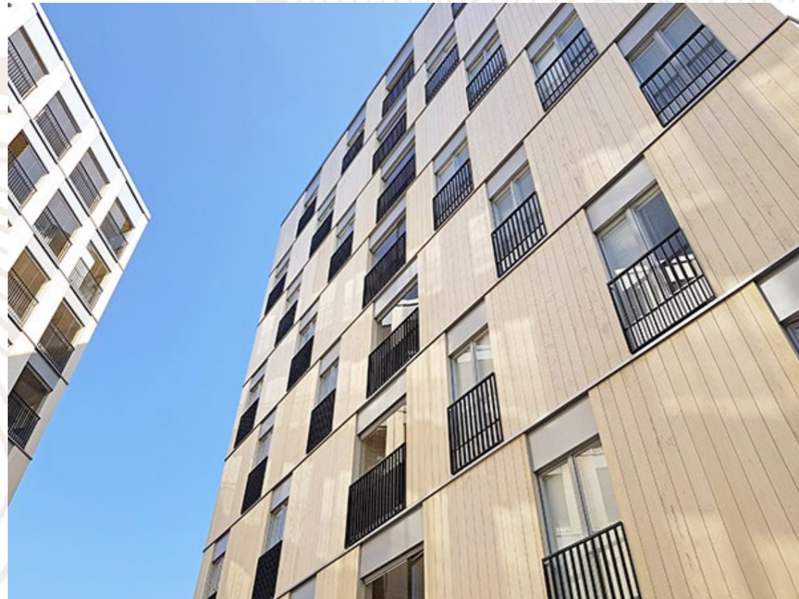
Kuva 19. Accoya® -tuotteella toteutettu julkisivu Helsingin Jätkäsaaren rakennetussa kerrostalossa. (Accsys 2022, B.)
