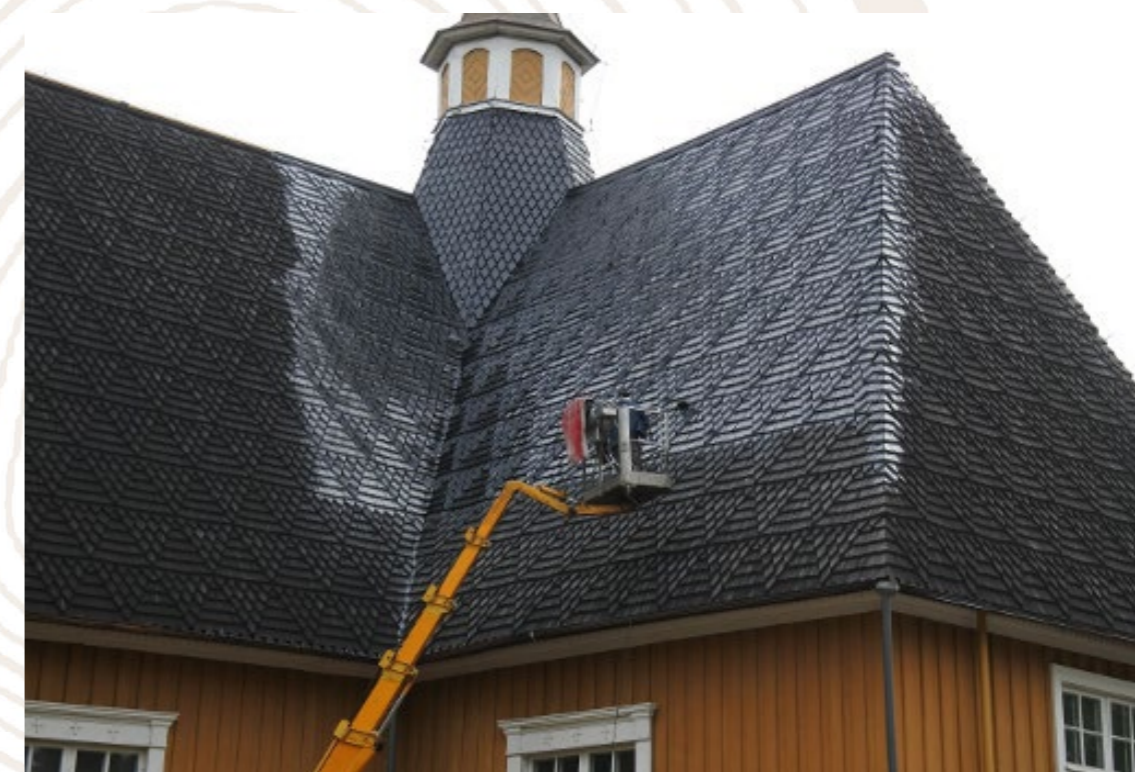
Kuva 27. Kirkon kattoa tervataan uudelleen. (Lemin kirjava 2017.)
