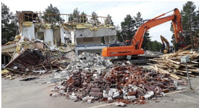
Kuva 9. Materiaalien lajittelua purkutyömaalla. (Rakennustarkkailija 2021)
