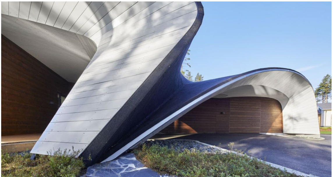
Kuva 11. Honkatalojen rakennuttama moderni hirsirakennus (Honkatalot)
