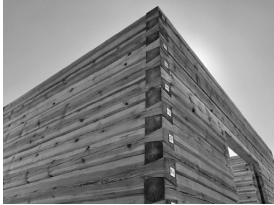
Kuva 1. Perinteinen lohenpyrstönurkka piharakennuksessa Haapaperhosentie 27 työmaalla 2021
