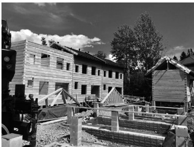
Kuva 7. Aarreaittojen työmaa Haapaperhosentie 27, Helsinki 2021
