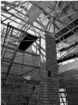
Kuva 5. Pilottihankkeen asunnon A piippua muurataan 2021. Piippu pinnoitetaan savilaastilla.
