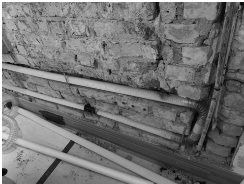
Kuva 4. Kuivatuskanaviston asennusta seinään sisään
