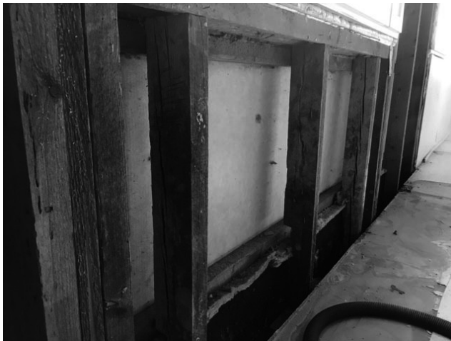
Kuva 1. Esimerkki valesokkelirakenteesta ennen kengitystä.
