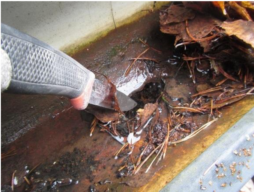
Kuva 38: Räystäskouru puhki
