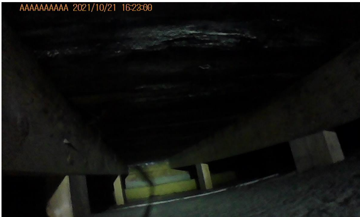
Kuva 33: Endoskooppikameran kuva saunaosan yläpohjasta.
