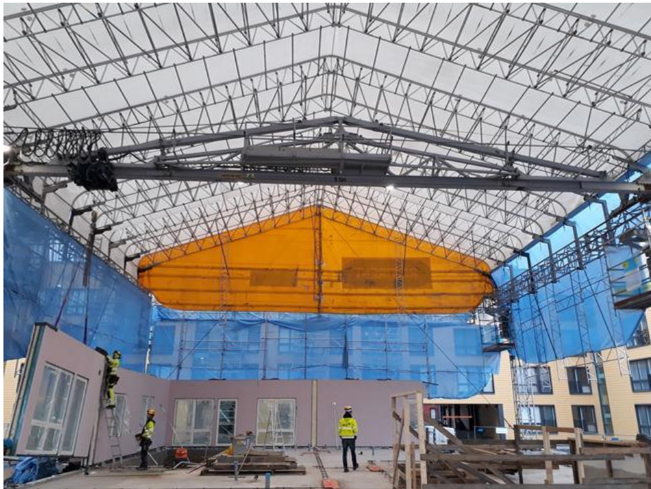
Kuva 3: Puuelementin asennusta nostettavan sääsuojan alla siltanosturin avulla (Törmänen 2019)
