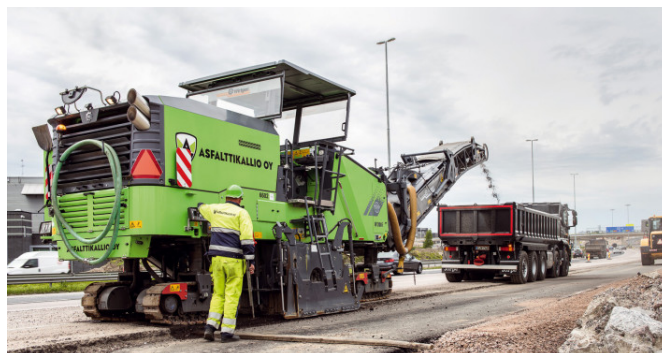
Kuva 6. Asfalttipäällysteen jyrsimää (Asfalttikallio 2020).
