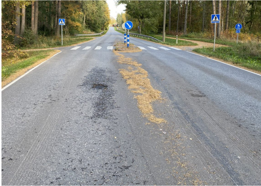
Kuva 18. Kohteessa 2 purkauma edennyt reiäksi.
