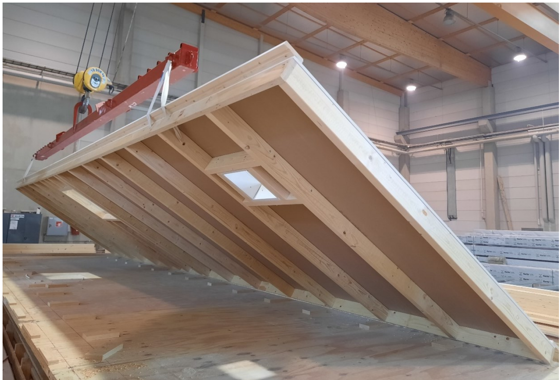
Kuva 16. Alapohjamoduulin nostaminen kokoonpanopöydältä.
