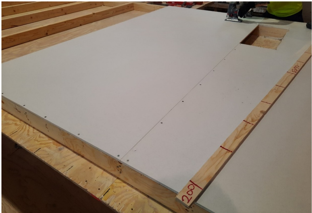
Kuva 15. Kipsilevyjen asennus ja levyn sahaus läpiviennin kohdalla
