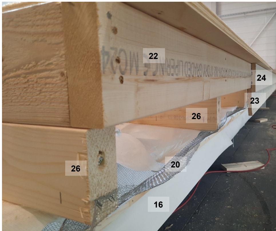
Kuva 21. Levytysvaiheen sisältämä räystäsrakenteiden toteutus näytettynä liitteen B rakenneosanumeroinnin mukaan
