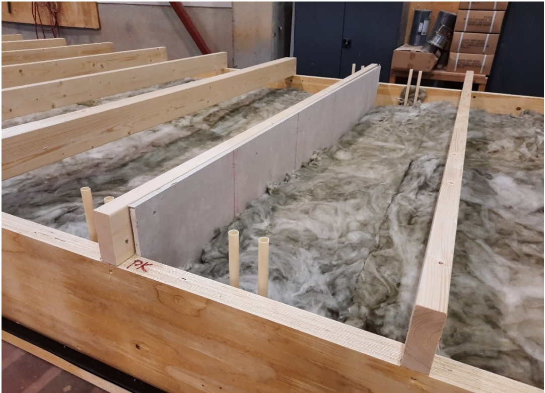
Kuva 20. Elementin vesikaton palkisto, palokatkolevytys ja reunatiiviste
