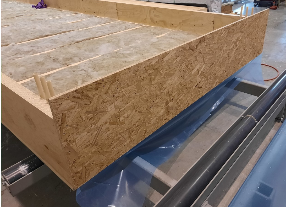
Kuva 18. Elementin päädyn levytys runkovaiheen lopussa
