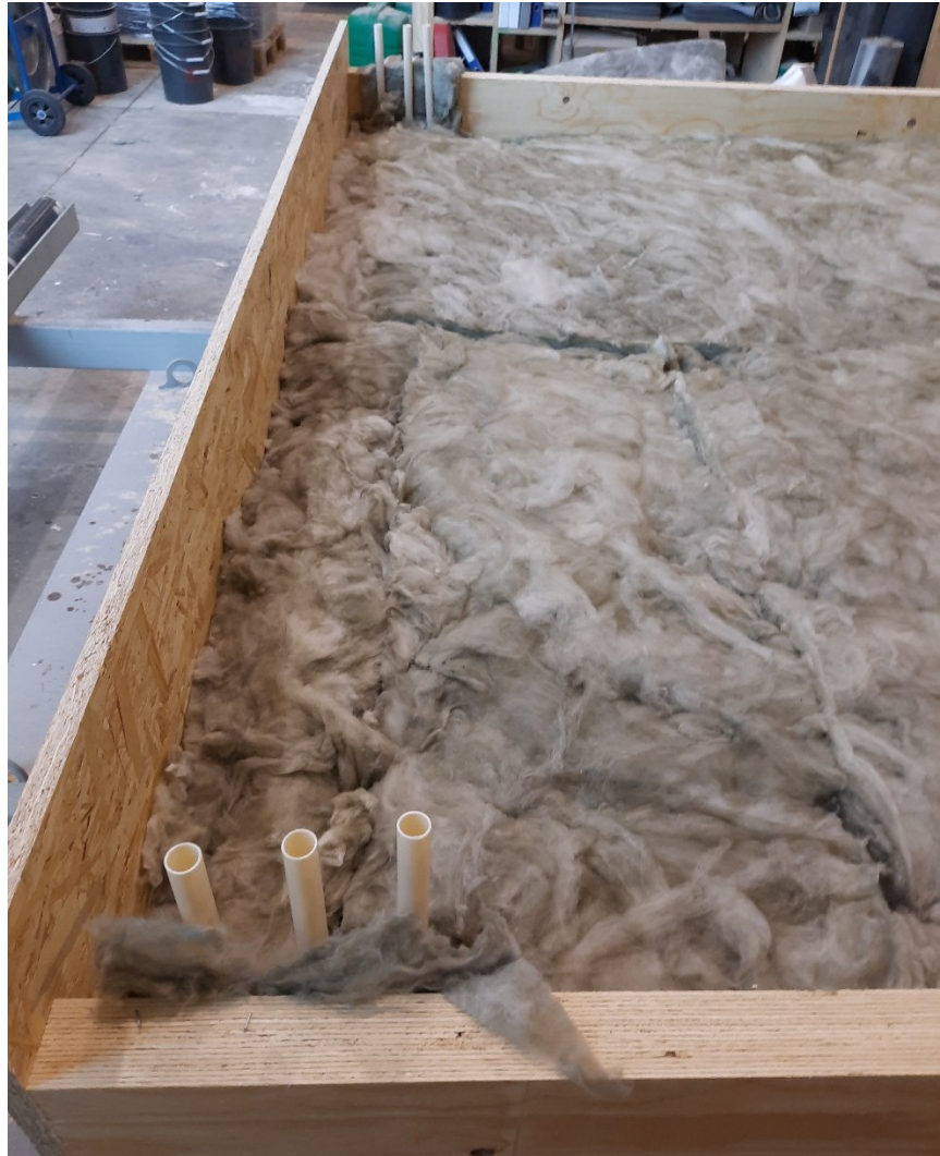
Kuva 19. Elementin lämmöneriste kokonaan asennettuna
