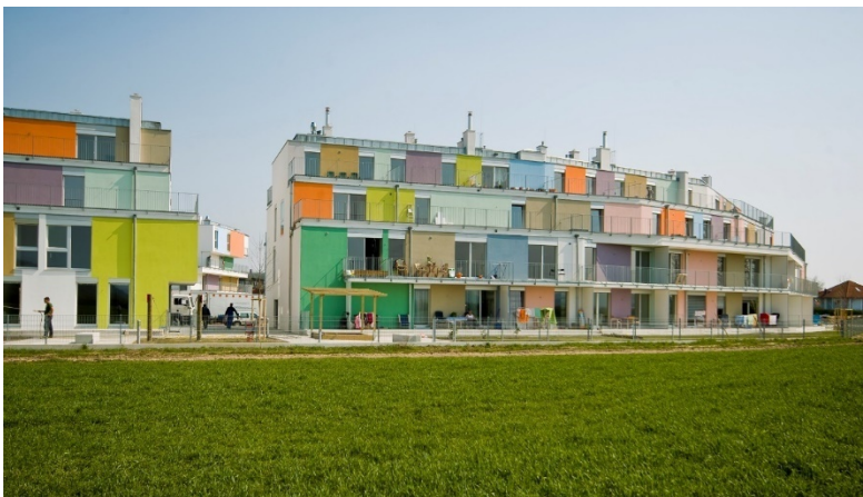
Kuva 25. Wohnhof Orasteig, ulkokehän julkisivu ja kiertävä yhteispiha
