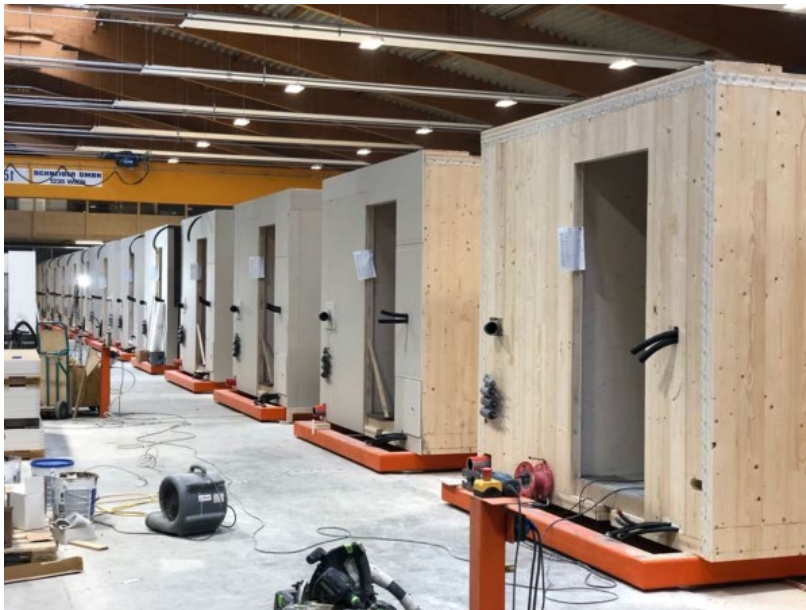
Kuva 1. Tilaelementtejä tehtaalla. (Kuvaaja: Markku Karjalainen)
