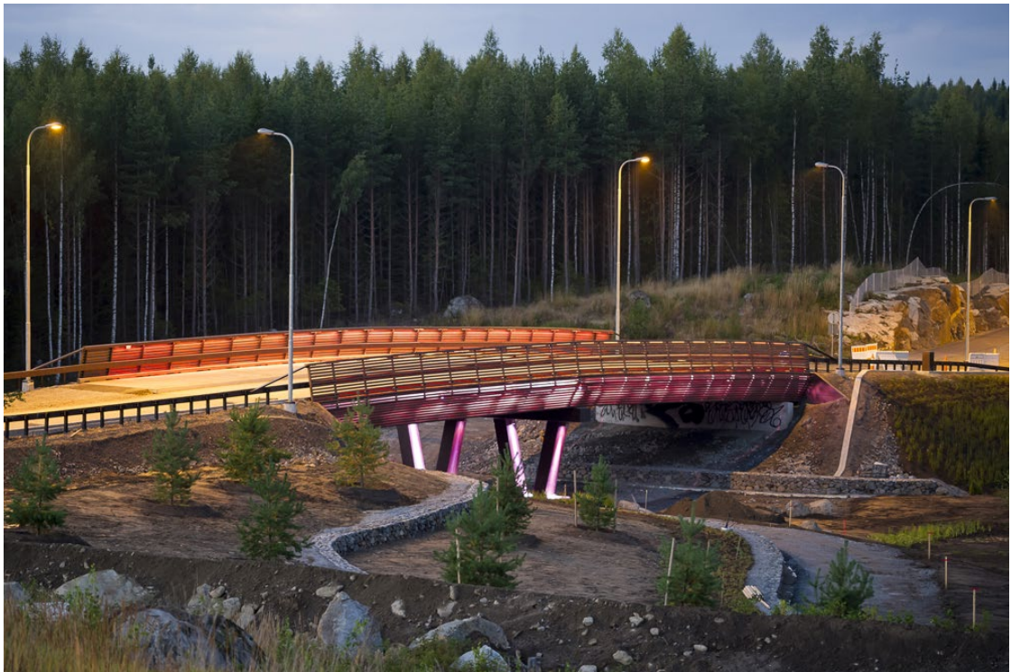
Kuva 7. Insinööritoimisto Suunnittelukide Oy:n suunnittelema Tampereen Vuoreksessa sijaitseva Tervasilta (Puuinfo Oy 2020d)
