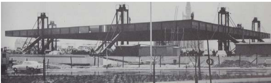
Fig.6: Galería Nacional de Berlín (izado de la cubierta), Mies van der Rohe, 1967.
