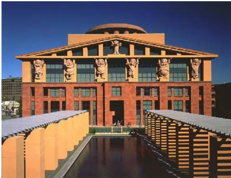
Fig. 10: Edificio Disney en Burbank, Michael Graves, 1986.
