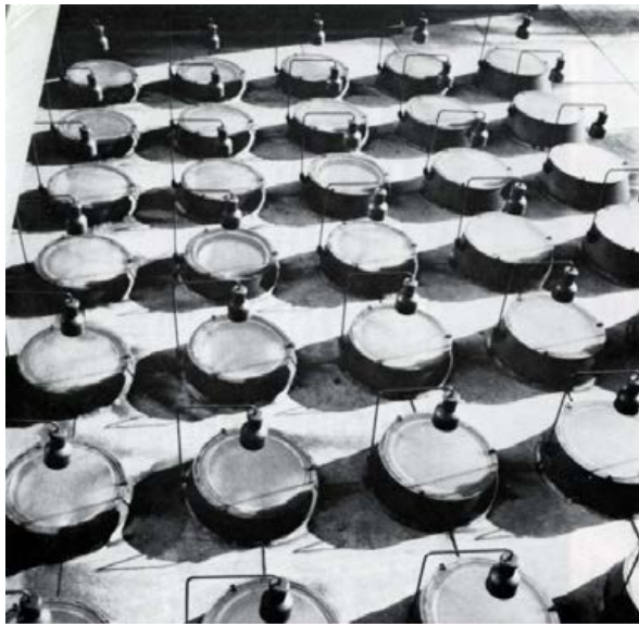
Fig.17: Lucernario equipado. Edificio comercial y de oficinas Rautatalo. Alvar Aalto.
