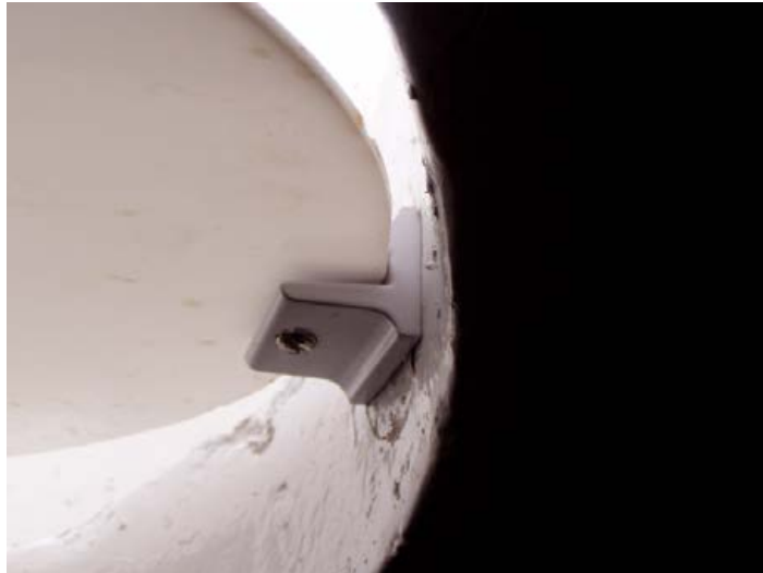
Fig.11: Lucernario equipado. Casa Domínguez, Alejandro de la Sota. Fotografía del autor.
