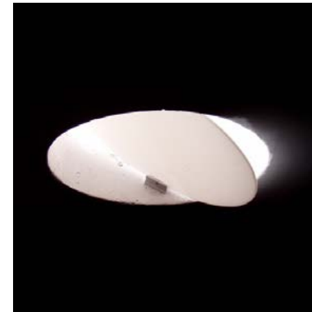
Fig.14: Lucernario equipado. Casa Domínguez, Alejandro de la Sota. Fotografía del autor.
