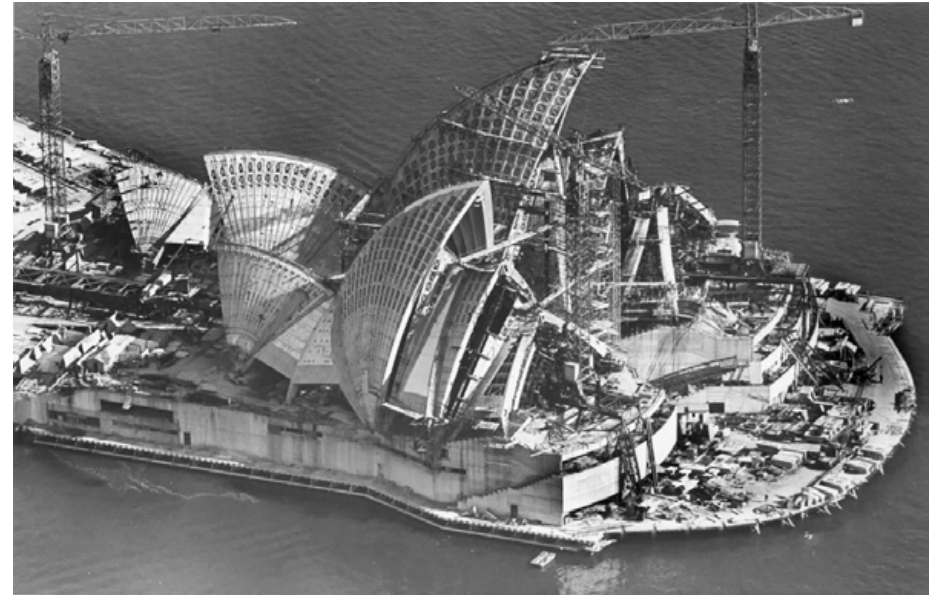
Fig.7: Opera de Sídney (en construcción), Jørn Utzon, 1966.
