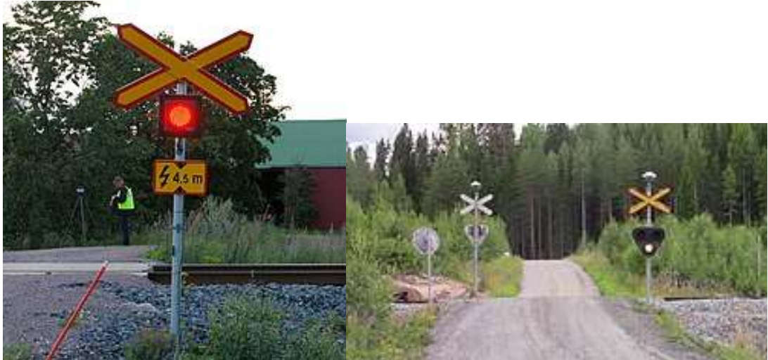
Kuva 2. Valovaroituslaitos sekä valo- ja äänivaroituslaitos (Wikipedia 2021).
