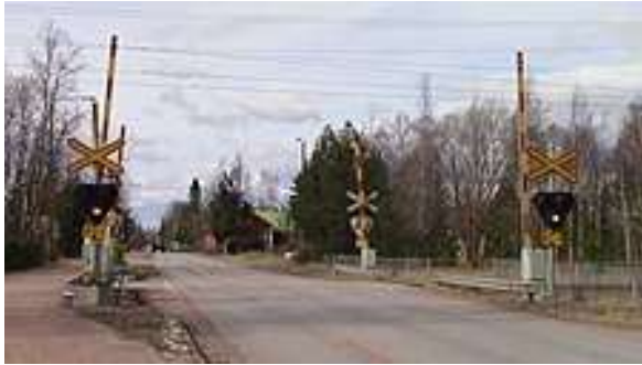
Kuva 4. Paripuomilaitos Mellilän tasoristeyksessä Loimaalla (Wikipedia 2021).
