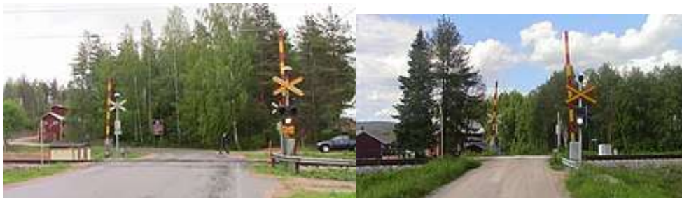
Kuva 3. Puolipuomilaitos ja kokopuomilaitos (Wikipedia 2021).
