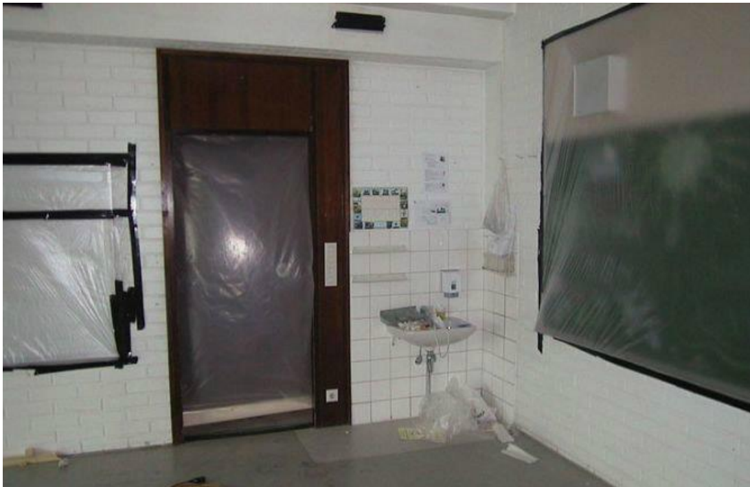
Kuva 2. Osastointi käyttäen valmiita rakenteita. Alipaineisuus havaittavissa sisään-päin pullistuneista muoveista. (Sisäilmayhdistys)
